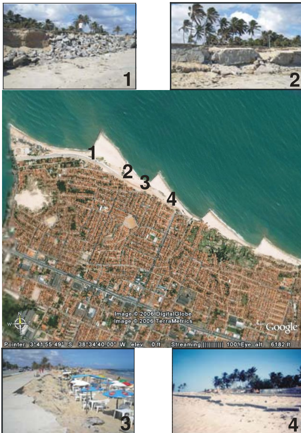
FIGURA 10: Trechos da Avenida Costa Oeste destruída pela maré - 2006.
