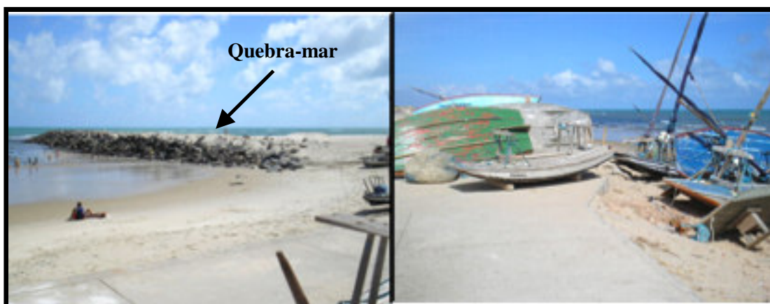
Figura 30: O paredão em frente ao porto das jangadas (à esquerda); as jangadas em cima do calçadão da Avenida Costa Oeste (à direita).
