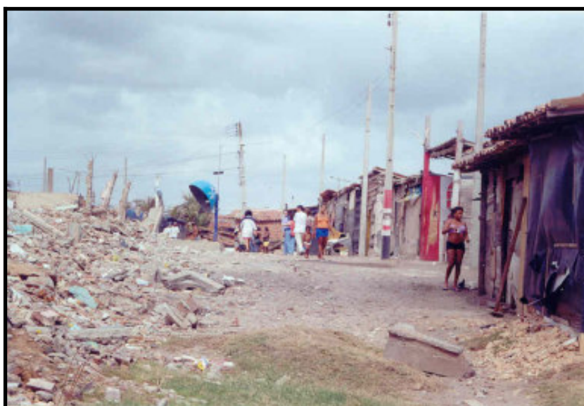
Figura 20: Instalação de novos barracos, semanas depois da remoção dos antigos, Pirambu.
