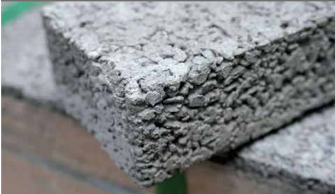
Figura 82 – Pavimento de concreto permeável
