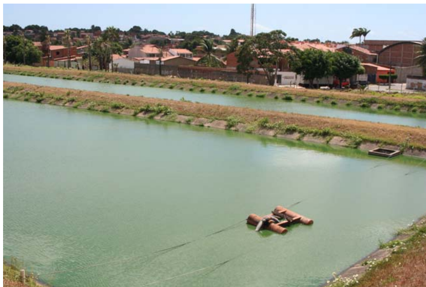
Figura 2.7. Lagoa de Estabilização do Sistema Isolado Tupã Mirim
