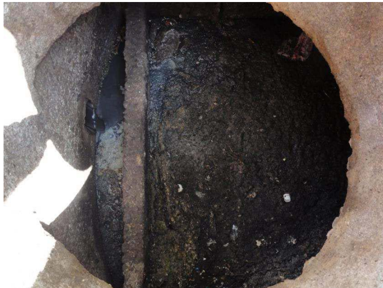
Figura 7.6. ETE Genibaú 40 – Calha do filtro obstruída
