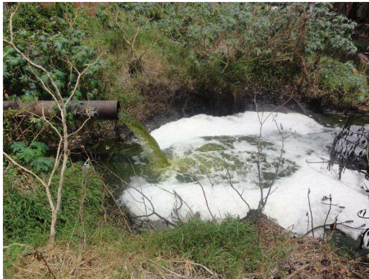
Figura 7.14. ETE Conj. Ceará 4ª Etapa – Saída do efluente com bastante espuma.
