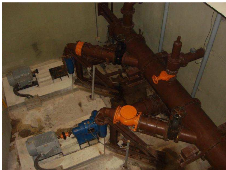
Figura 7.16. EE Parque Ecológico - Das três bombas, apenas uma estava funcionando, uma estava em manutenção e outra estava ausente;
