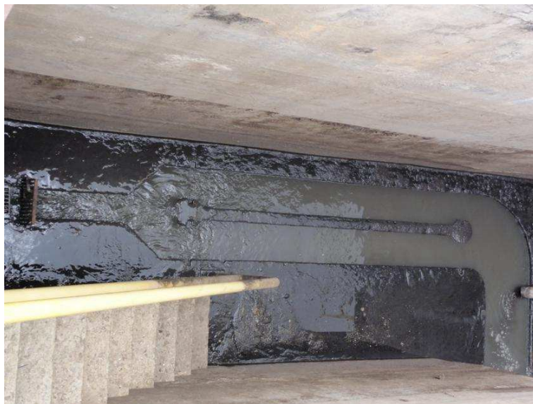
Figura 7.1. EE Souza Pinto - Gradeamento e caixa de areia afogados
