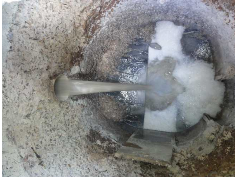
Figura 7.13. ETE Conj. Paupina – Saída do efluente com bastante espuma.
