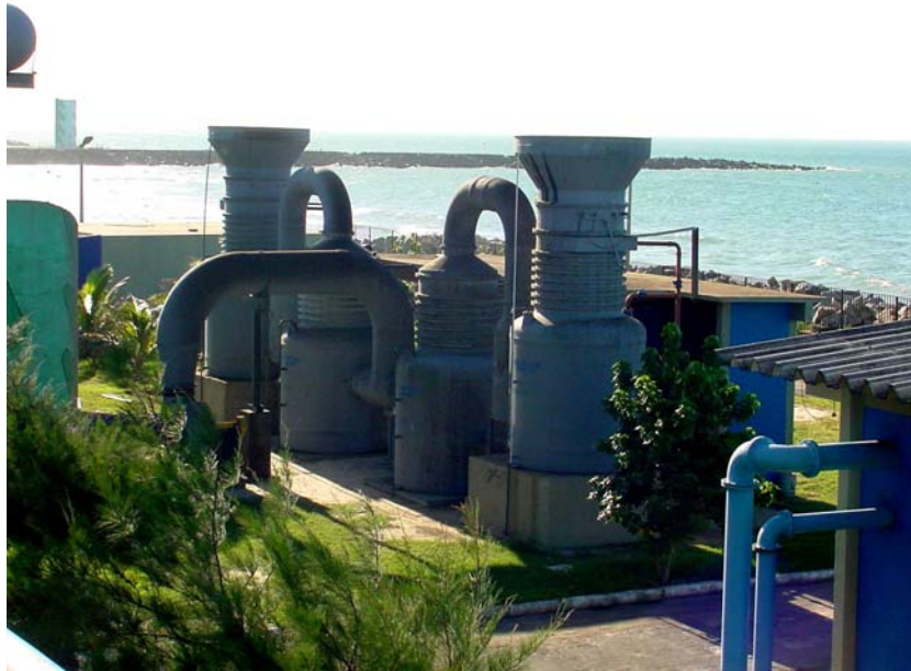
Figura 2.9. Estação de Tratamento de Odores
