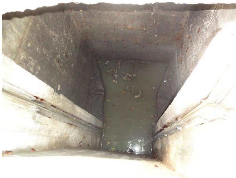
Figura 7.2. EE Parque Rio Branco – Gradeamento afogado
