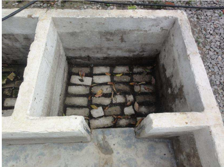
Figura 7.7. Novo Mondubim II - desgaste do leito de secagem
