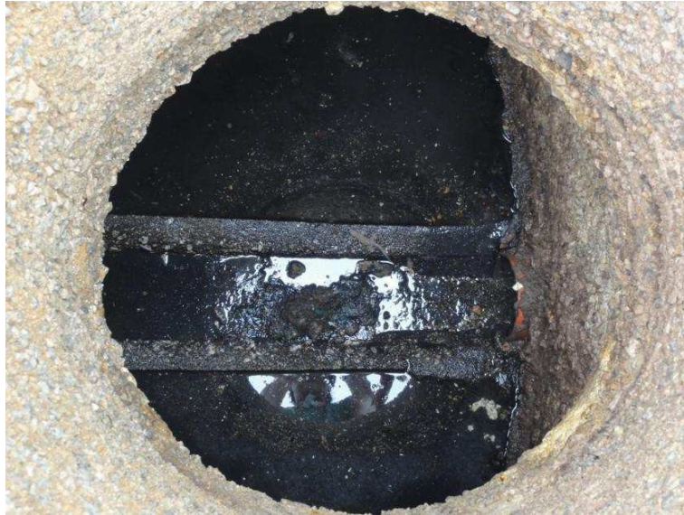
Figura 7.5. ETE Campo dos Ingleses 01 - Ausência de manutenção
