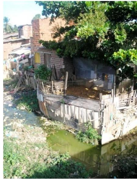
Figuras 2.42 e 2.43 – Comunidade às margens do rio Beberibe, no bairro Cajueiro, entre Recife e Olinda. Notar as residências construídas com materiais improvisados, em local inadequado à ocupação, e com a introdução de aterros para evitar as inundações. Fonte: fotos do autor, junho de 2008.
