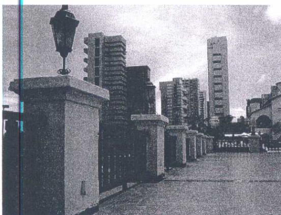
Vista do terraço a norte da ala oeste.
