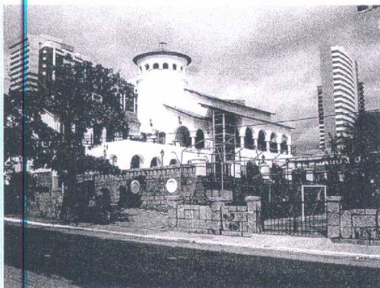
Vista do imóvel a partir da av. Rui Barbosa, com destaque para a poluição visual causada pelo gradeado das quadras.
