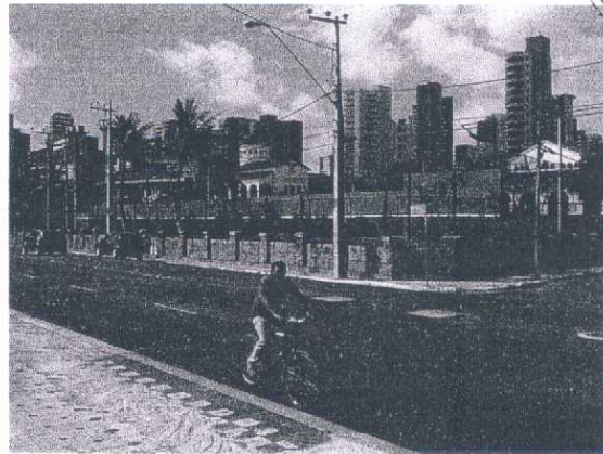
Vista do imóvel a partir da avenida Hist. Raimundo Girão, com visibilidade prejudicada pelo muro de pedra e pela cercadura das quadras esportivas.
