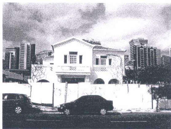
Vista do edifício residencial de interesse situado à Avenida Beira-Mar, a partir do calçadão da orla marítima.
