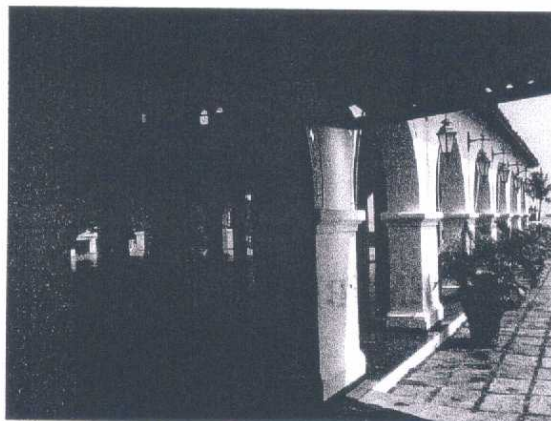
Vista dos pórticos de arcadas da ala oeste, a partir do pórtico de ligação com a ala sul.
