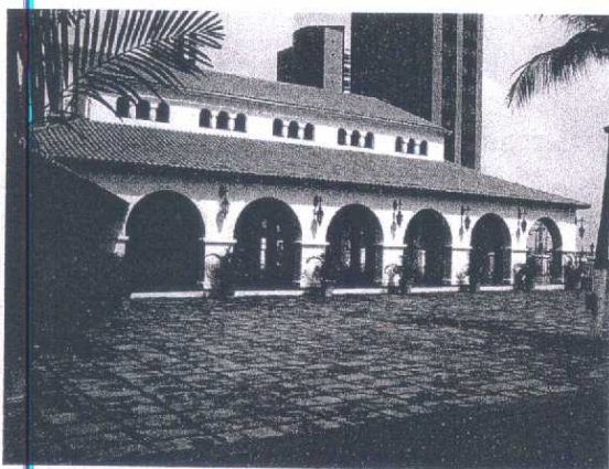
Vista da ala oeste, a partir do terraço, na ala sul.
