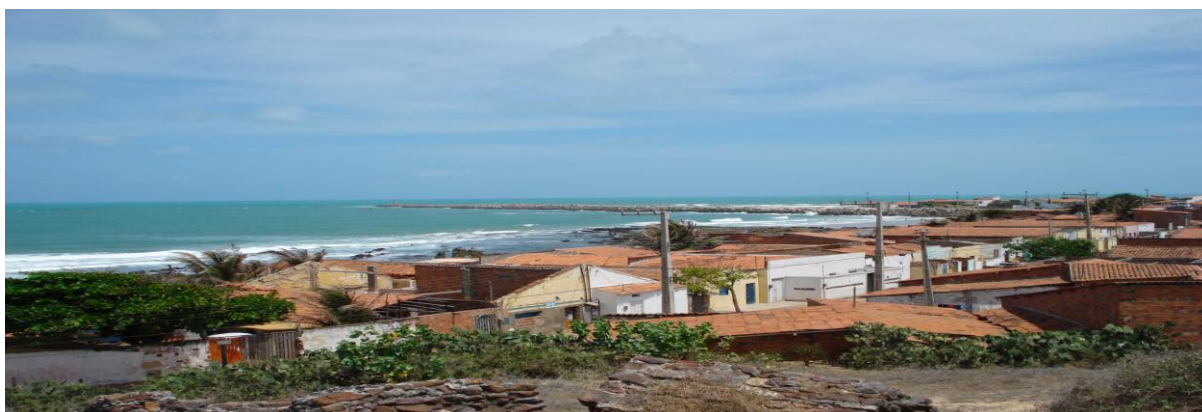
Figura 3: Ocupação da orla marítima de Fortaleza. Localidade - farol do Mucuripe Fonte: Arquivo da autora em 27 de novembro de 2007
