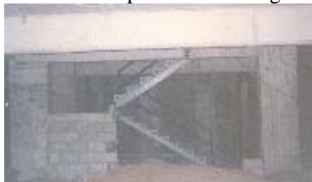
Figura 2 - Vista Lateral da Escada Industrializada
