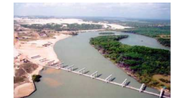
Vista do rio cocó com a ponte em processo de construção. Fonte: Meireles, 2004
