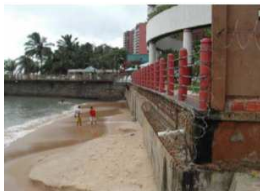
Estreita faixa de praia com muro de concreto e edificação. Fonte: Meireles, 2005
