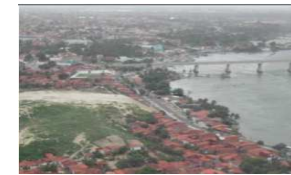
Vista da Duna e ponte sobre o rio Ceará – Adensamento populacional. Fonte: Meireles, 2005
