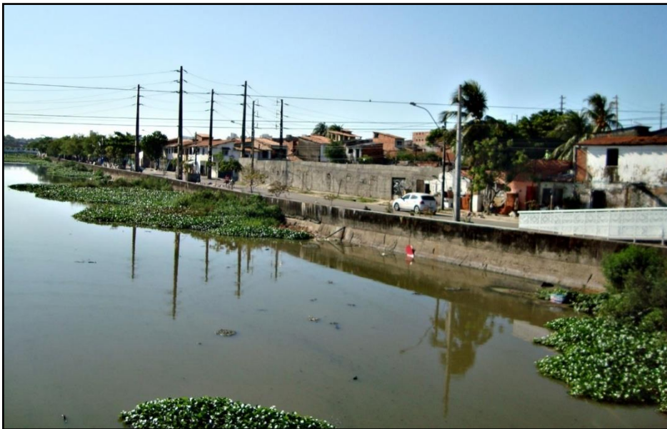
Figura 31 – Ocupação da planície de inundação do riacho Tauape por infraestrutura urbana e unidades residenciais unifamiliar e multifamiliar
