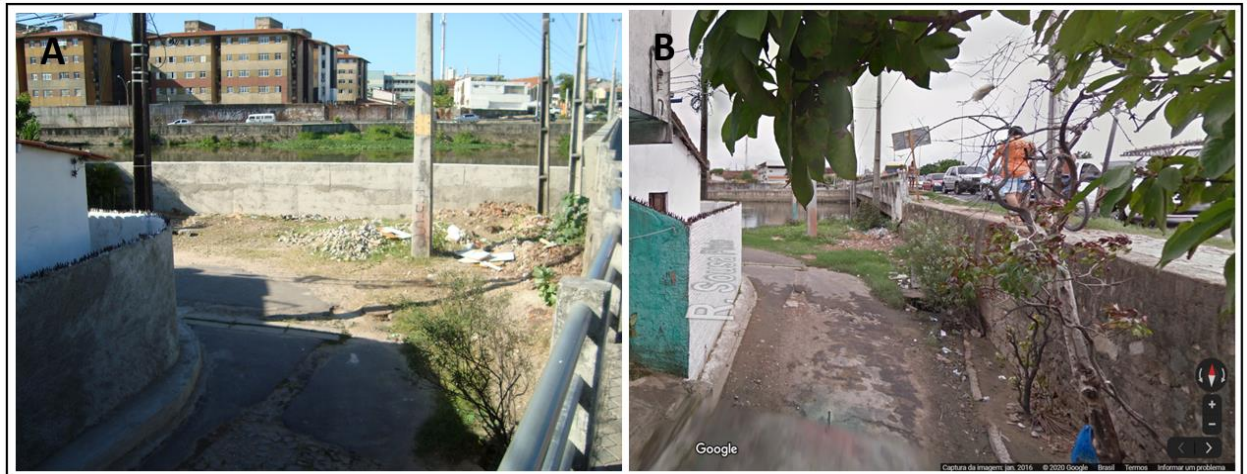
Figura 15 – Ponto de alagamento na rua Sousa Pinto
