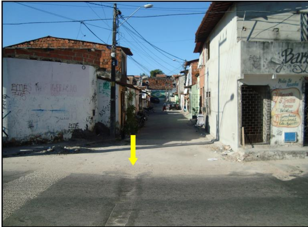
Figura 22 – Obra de drenagem realizada na travessa Alegria
