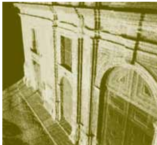
Fig. 4.26 – Nuvem de pontos da fachada da Igreja de São Francisco (Fonte LCAD).
