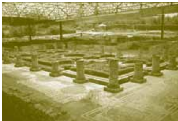
Fig. 5.1 – Projeto arquitetônico para proteção de ruínas romanas de Conimbriga, Portugal. Foto do autor.
