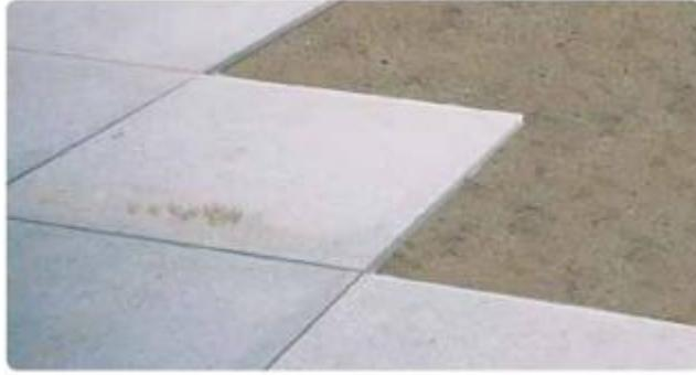
**Figura IV-3.30: Placas assentadas em material granular - sistema flutuante.**
