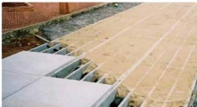
**Figura IV-3.32: As placas também podem ser utilizadas como piso elevado externo. Fonte:**
