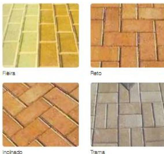
**Figura IV-3.28: Estilos de assentamento dos pavimentos intertravados.**
