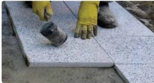
**Figura IV-3.31: Placas assentadas sobre argamassa - sistema aderido.**
