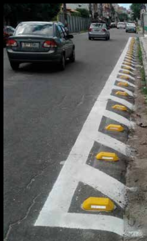
FIGURA 47 - SINALIZAÇÃO IMPLANTADA - ESQUINA SEGURA
