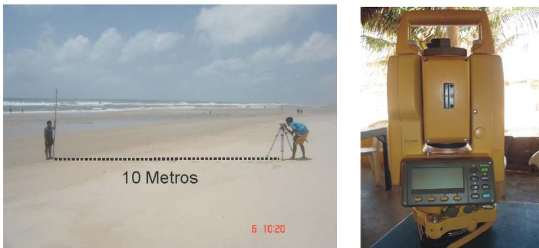
**Figura 5:** Levantamento topográfico com auxílio de estação total ou nível topográfico.
