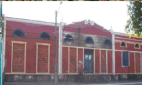
Foto 6: Prédio da antiga alfândega - futura pinacoteca do Ceará.
