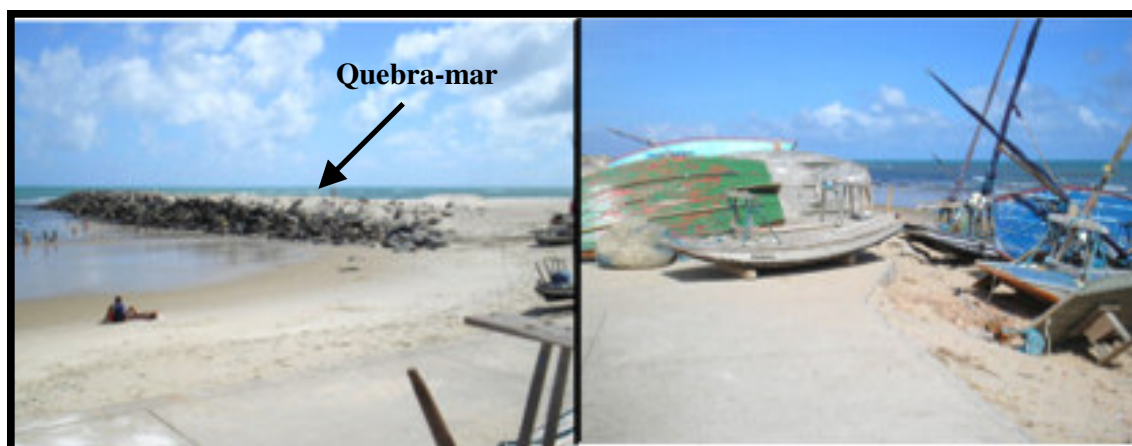
Figura 30: O paredão em frente ao porto das jangadas (à esquerda); as jangadas em cima do calçadão da Avenida Costa Oeste (à direita).
