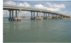
Foto 3: Ponte sobre o rio Ceará.
