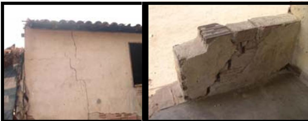
Figura 12: Casas com rachaduras – “assentamento” Cacimba Nova.
