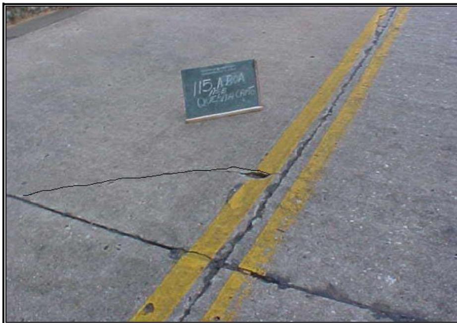
**Figura 3.11:** Fissura de Canto, DNIT (2004)
