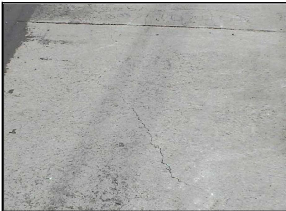
**Figura 3.18:** Fissura Superficial, DNIT (2004)
