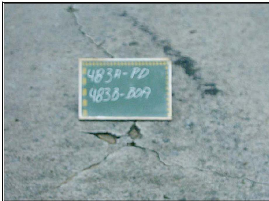
**Figura 3.23:** Buracos em placa de concreto, DNIT (2004)
