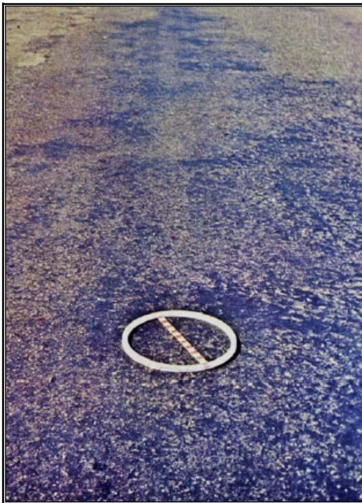
**Figura 3.9:** Exsudação no Pavimento, DNIT (2003)
