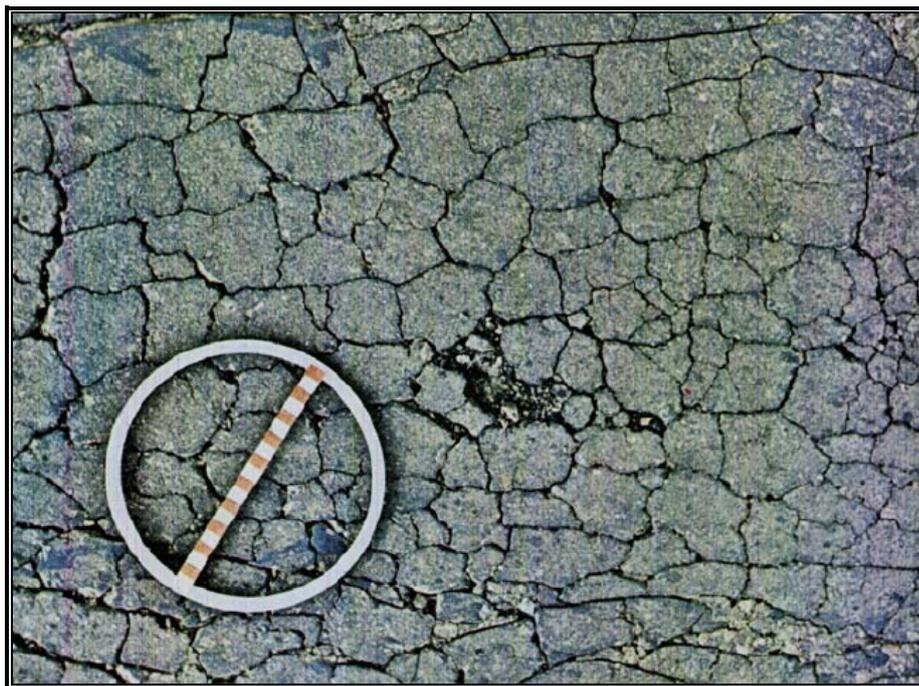
**Figura 3.1:** Trincamento por Fadiga, DNIT (2003)
