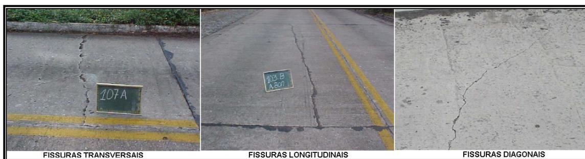
**Figura 3.14:** Tipos de Fissuras Lineares, DNIT (2004)
