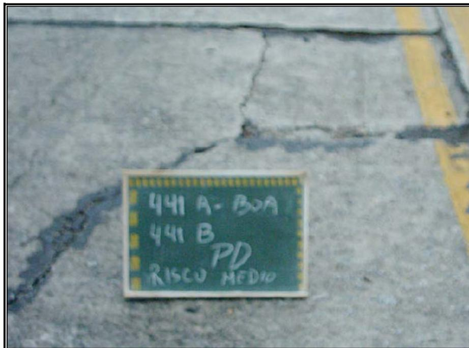
**Figura 3.22:** Assentamento em placa de concreto, DNIT (2004)
