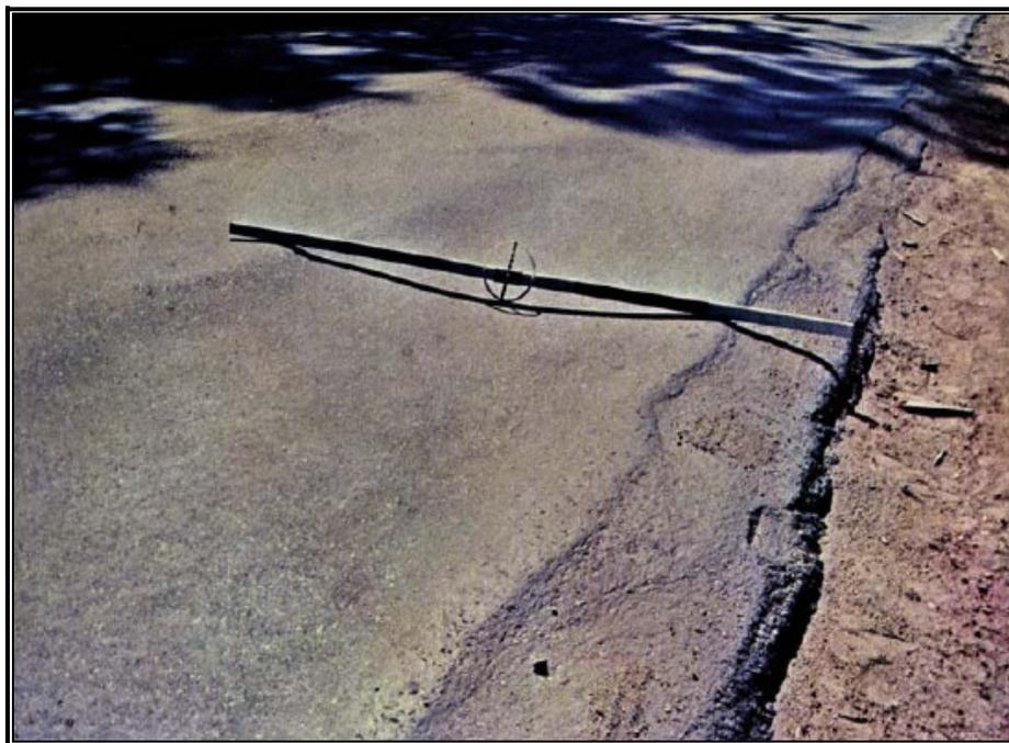
**Figura 3.8:** Afundamento de Trilha de Roda, DNIT (2003)
