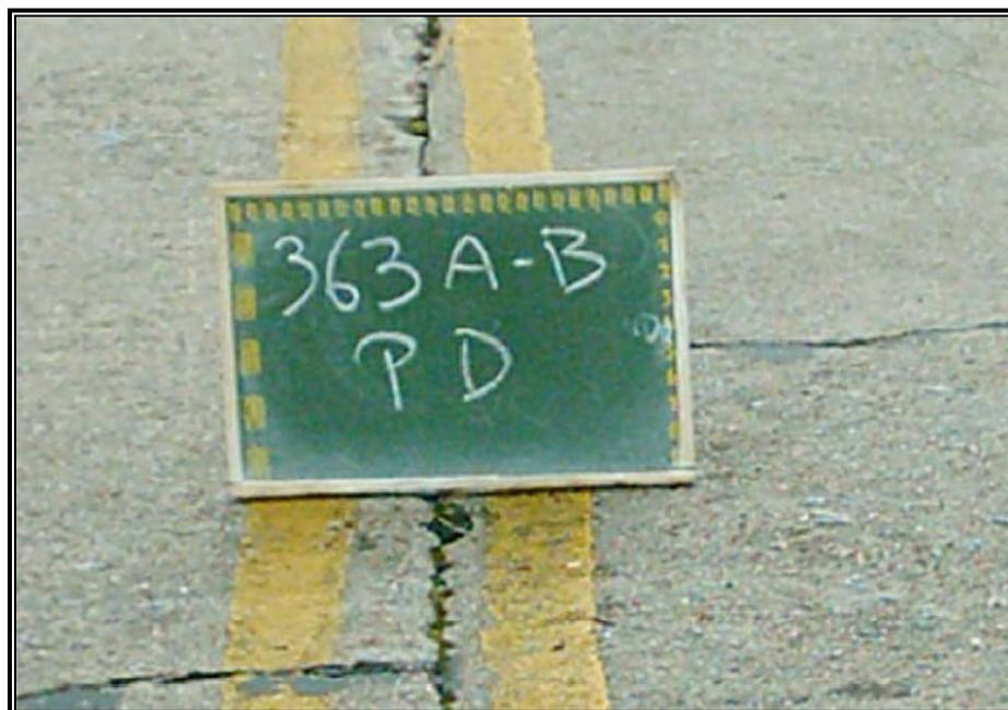
**Figura 3.13:** Falha na Selagem das Juntas, DNIT (2004)
