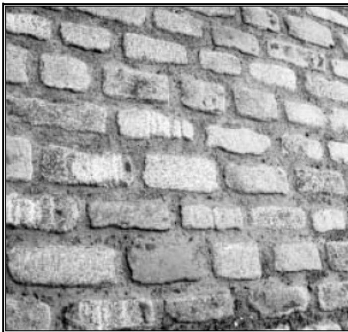
**Figura 5.10:** Exemplo de Revestimentos de Calçamento em Paralelepípedos
