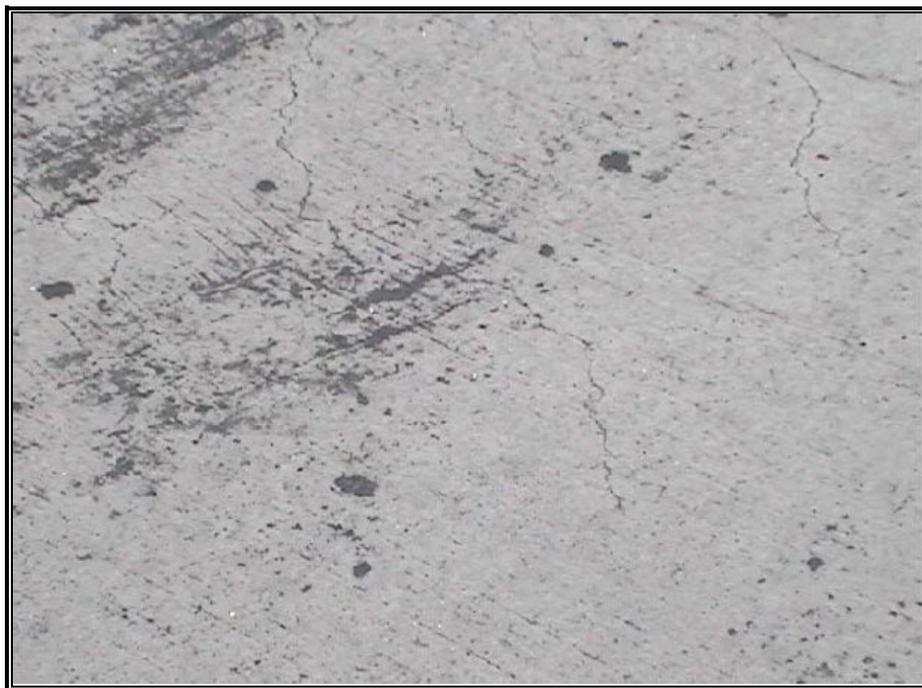
**Figura 3.19:** Fissura de Retração Plástica, DNIT (2004)
