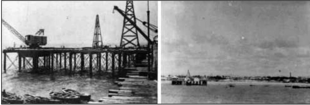
**Fig. 2.6** A antiga Praia do Peixe, atual Praia de Iracema, na época da construção da Ponte Metálica - Foto tirada em meados da década de 1910 – Fonte: Arquivo Nirez
