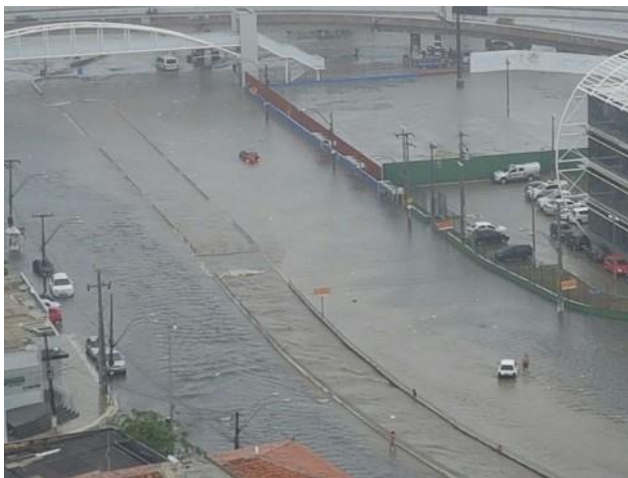
Figura 1 - Canal da Aguanambi transbordado em dia chuvoso. Fonte: Diário do Nordeste (2017)
