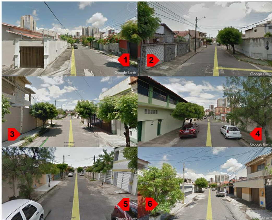
Figura 33 - Distribuição das sarjetas verdes na rua Artur Timóteo próximo à Avenida Aguanambi. Fonte: elaborado pela autora.
