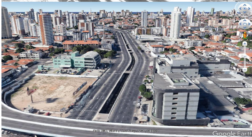
Viaduto da Av. 13 de Maio, e Av. Aguanambi pouco antes do início das obras de implantação do sistema de BRT em 2016.
