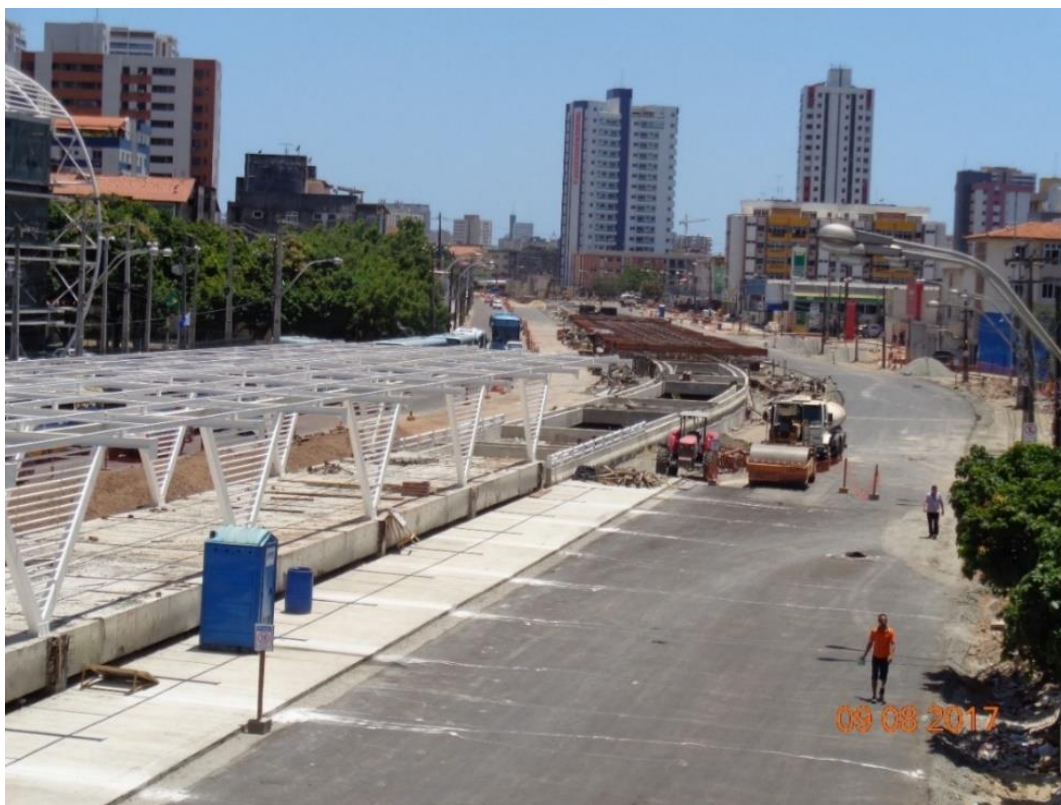
Figura 27 - Obra do BRT na Avenida Aguanambi em Fortaleza- CE Fonte: acervo pessoal da autora
