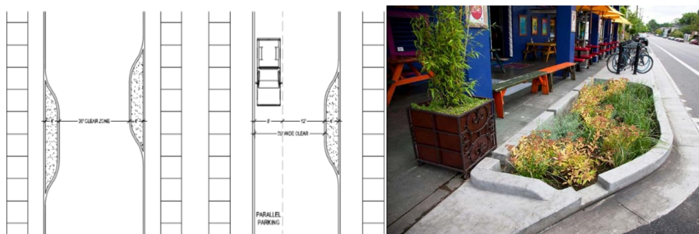
Figura 42 - Sarjetas verdes são áreas de paisagem do lado da rua que armazenam, filtram e infiltram o escoamento de águas pluviais.
