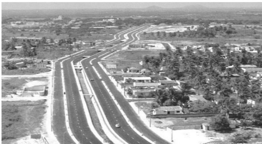
v. Aguanambi no ano de sua inauguração em 1972, ao fundo o cruzamento com a Av. 13 de Maio, ainda sem o viaduto.
