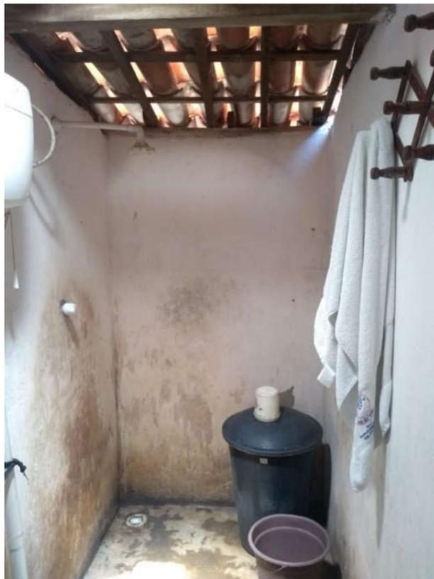
**Figura 1.** Banheiro sem revestimento.
