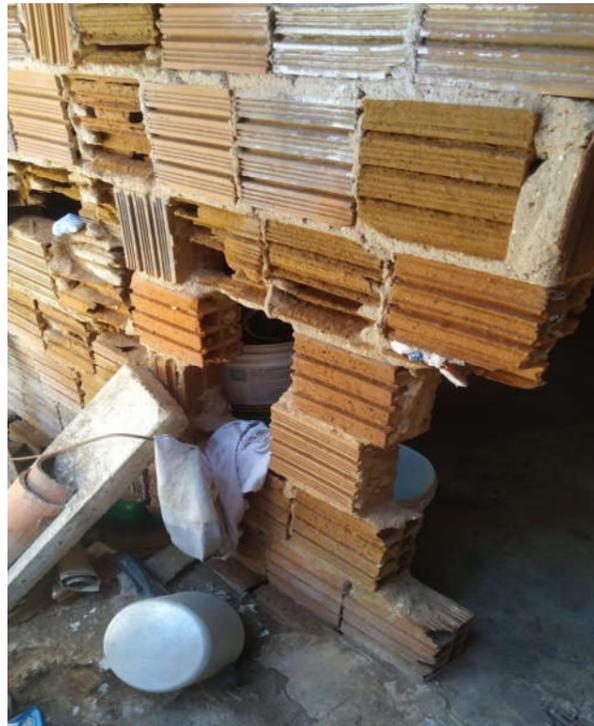
Figura 3. Parede com falta de tijolos.
