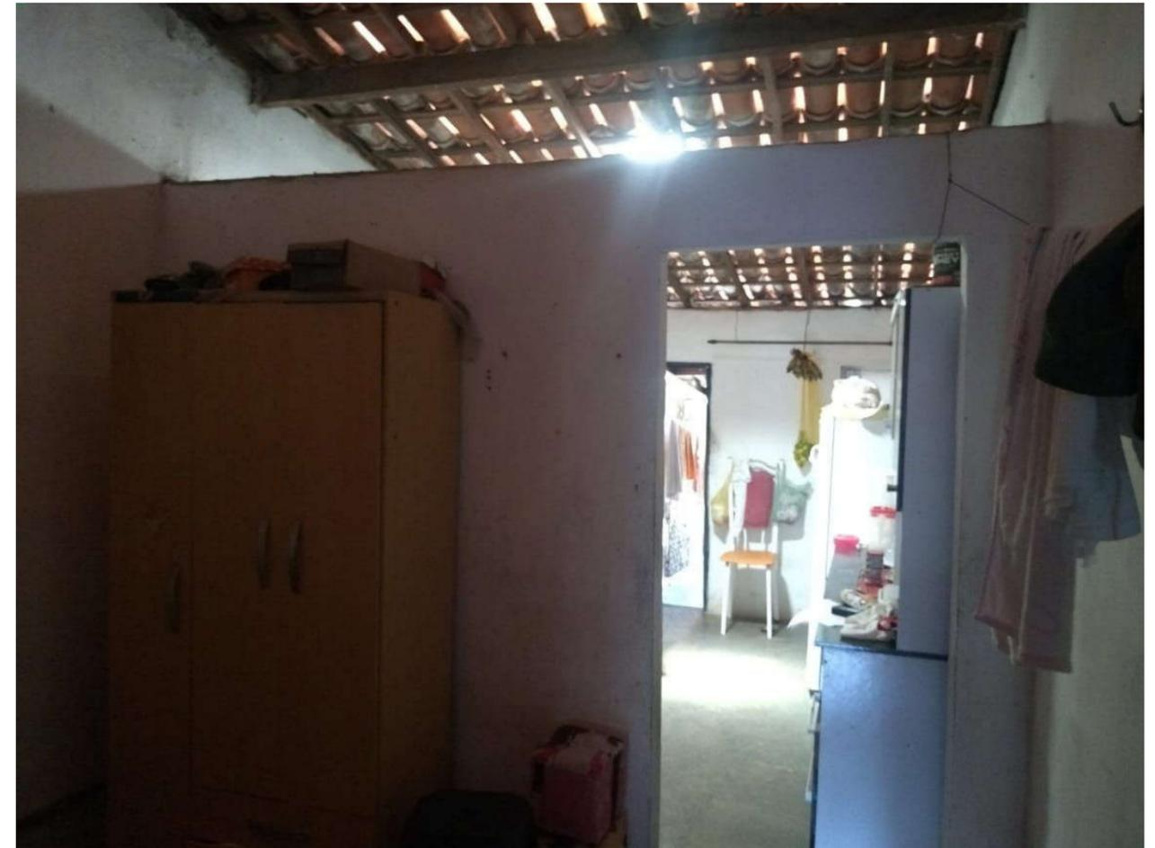
**Figura 3.** Meia parede, para fins de ventilação
