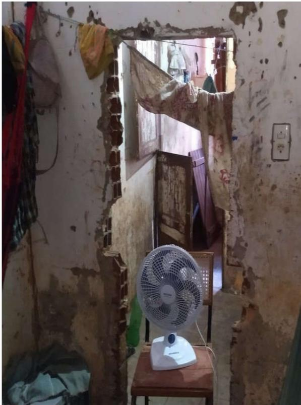
**Figura 1.** Parede, à esquerda do vão, com tijolos inacabados.
