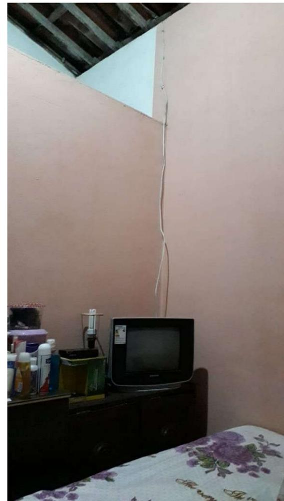
**Figura 2.** Presença de meia parede para auxiliar na ventilação
