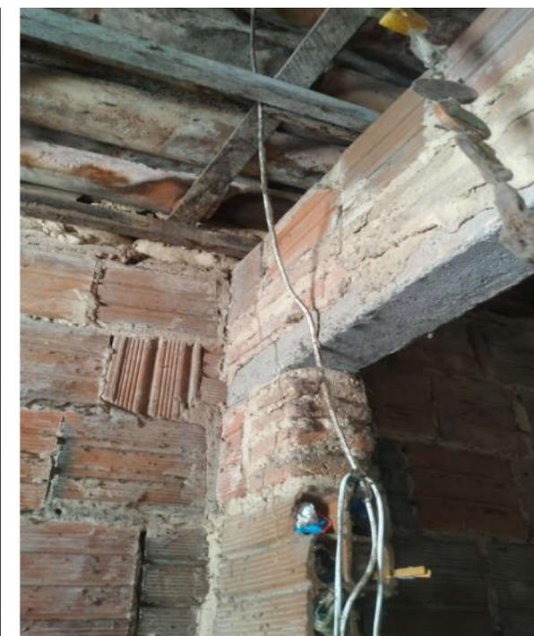
Figura 2. Parede do vizinho, apresenta infiltração e cupim.
