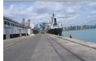
Ancoradouro do Porto do Mucuripe, 2005. Fonte: Projeto Orla
