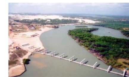
Vista do rio cocó com a ponte em processo de construção. Fonte: Meireles, 2004
