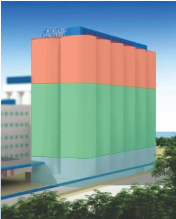
Construção dos silos incide sobre edifício existente (três pavimentos) ocupando o terreno até limites com a Av. Vicente de Castro e via Interna (sem recuo frontal) com elevação do gabarito existente de 12,00m para 72,00m (aproximadamente).
