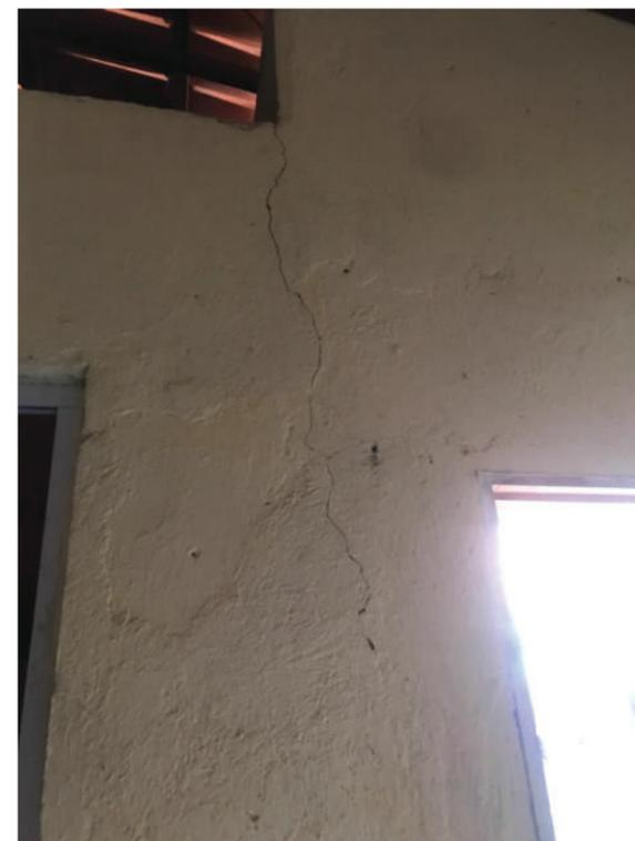
Figura 1. Rachadura na parede: precariedade estrutural.
