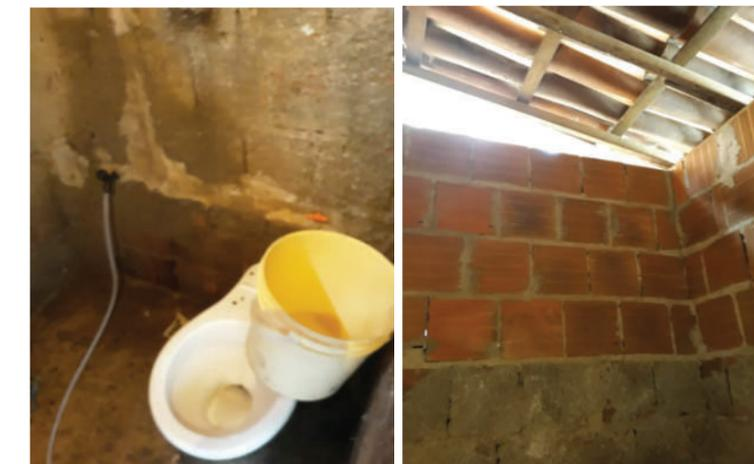
Figuras 3 e 4: Vaso sanitário ligado ao canal e desnível entre parede e telhado.
