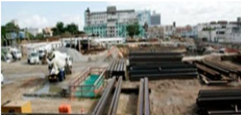
Figura 3 - Obras do Metrofor
