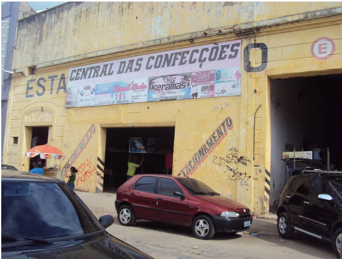
Foto 05 – Galpão da Rua Icó.
