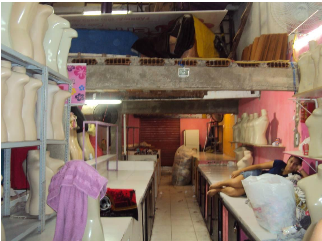
Foto 12 – Estrutura das bancas de um galpão.
