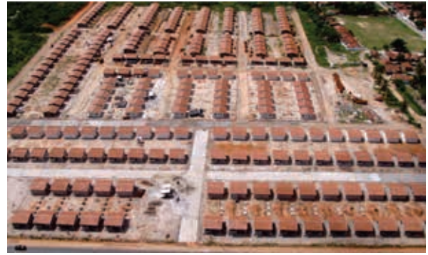
figura 2.3. exemplo de conjunto habitacional [segregação imposta]
