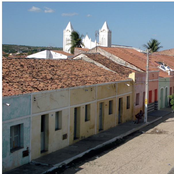
Conjunto de casas na Rua General Piragibe.
