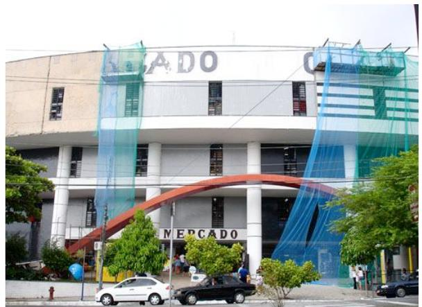
FIGURA 61: A fachada principal do mercado durante a substituição do revestimento externo (fonte: arquivo pessoal).
