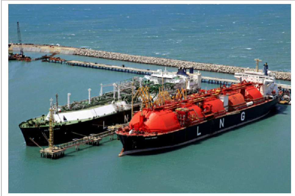
Ilustração 37 - Terminal de Regaseificação de Pecém
