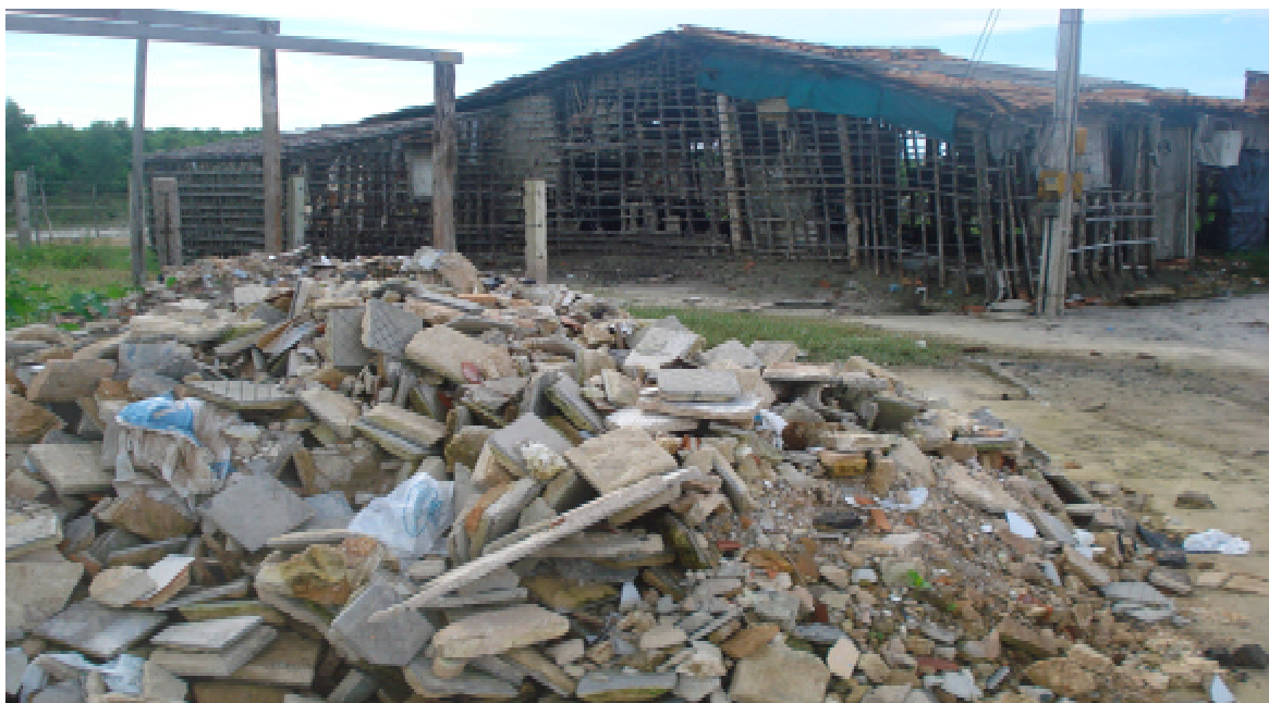
FOTO 5.4 – Aspectos de uma moradia no Conjunto Vila Velha IV, às margens do Rio Ceará. Observar a grande quantidade de entulho utilizada pelos moradores da comunidade para aterrar o mangue. Fotografia realizada pelo autor em 21 de Maio de 2008.
