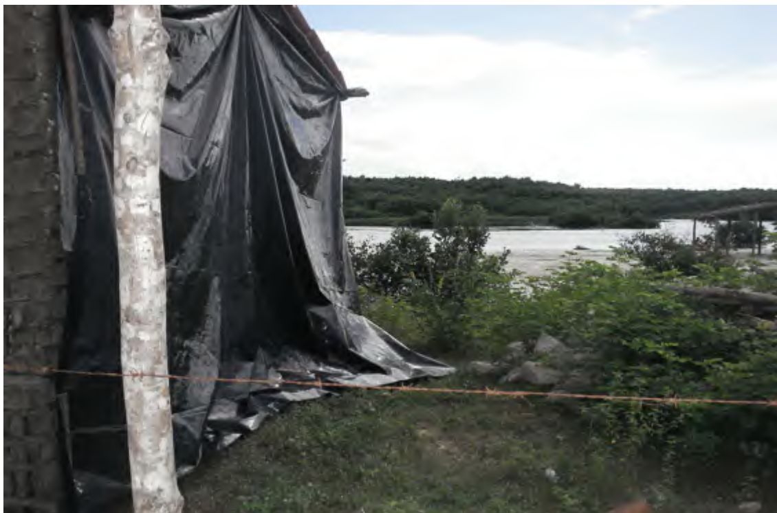
FOTO 11 – Aspecto de uma moradia próxima a um trecho da margem direita do Rio Ceará. Notar as precárias condições da moradia em questão. Fotografia realizada pelo autor em 09 de Maio de 2008.
