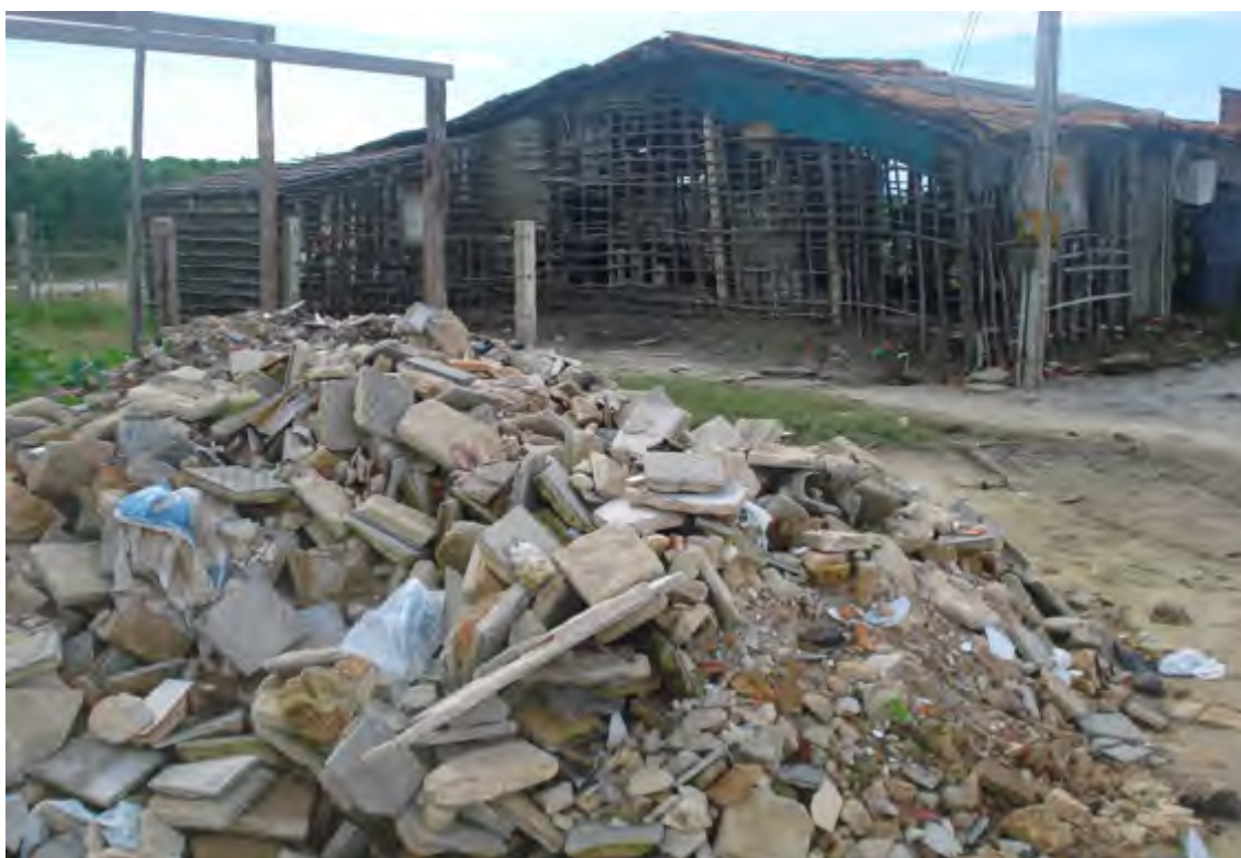
FOTO 24 – Aspecto de uma moradia da comunidade do mangue do bairro Vila Velha. Notar as precárias condições da moradia em questão e o monte de entulho utilizado pelos moradores para o aterramento e posterior construção de moradias em trechos inundados da comunidade. Fotografia realizada pelo autor em 21 de Maio de 2008.
