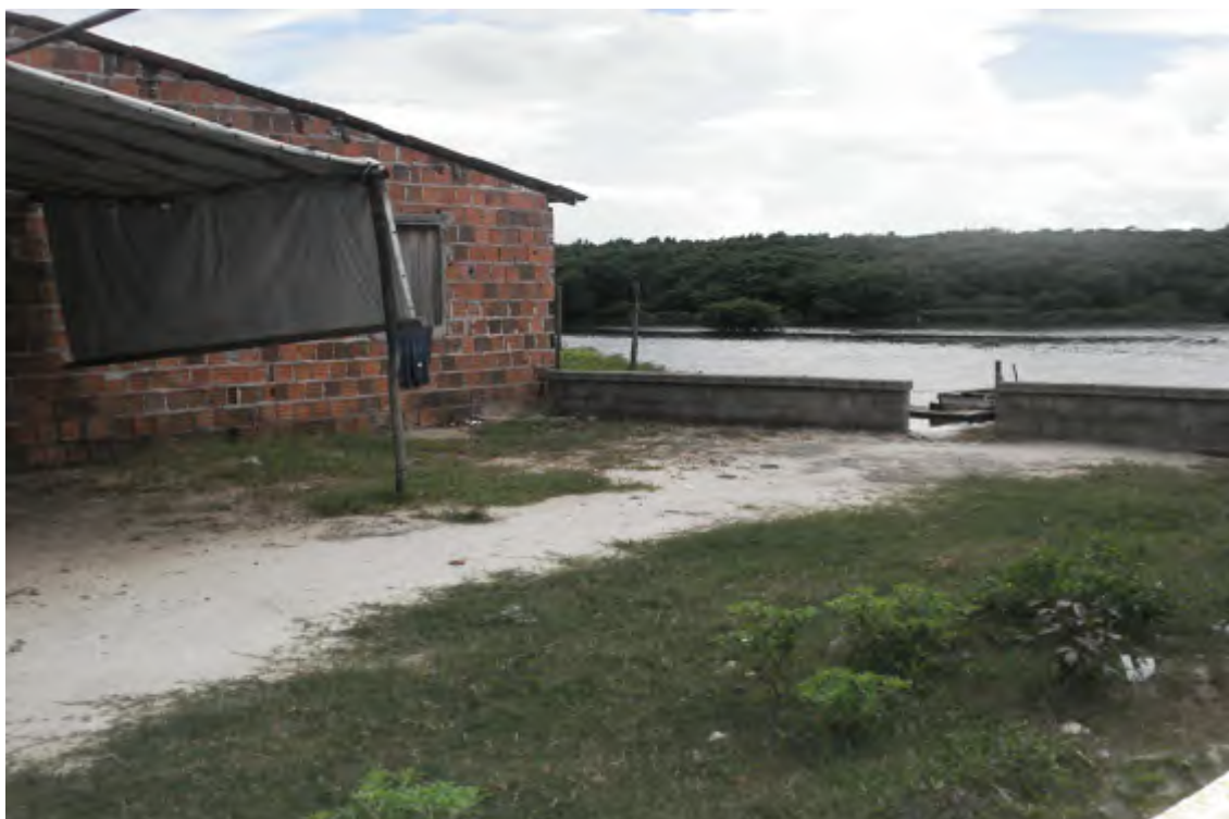
FOTO 10 – Aspecto de uma moradia próxima a um trecho da margem direita do Rio Ceará. Fotografia realizada pelo autor em 09 de Maio de 2008.
