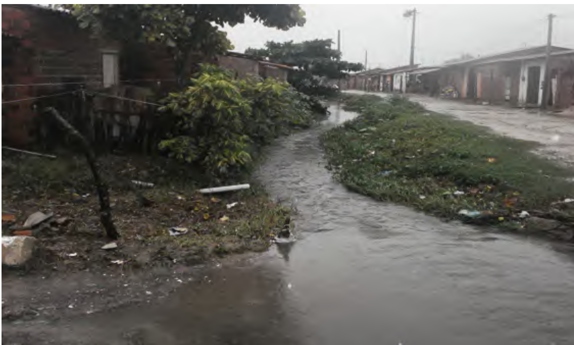
FOTO 2 – Aspecto da Rua Arthur Borges, principal rua de acesso à comunidade do mangue do bairro Vila Velha, em um dia chuvoso do mês de Abril de 2008. Fotografia realizada pelo autor em 11 de Abril de 2008.
