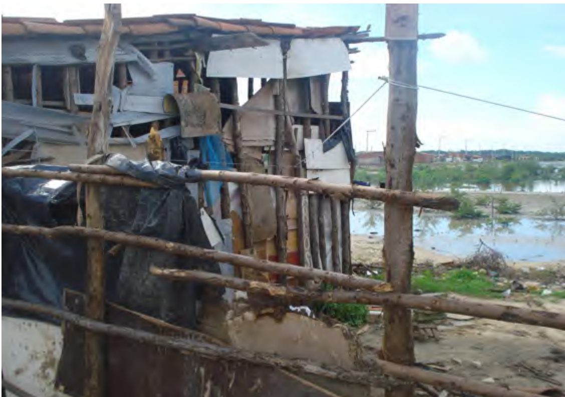
FOTO 29 – Aspecto de uma moradia da comunidade do mangue do bairro Vila Velha. Notar as precárias condições da moradia em questão e área inundada pelas oscilações de maré da planície flúvio-marinha, em um trecho à margem direita do Rio Ceará. Fotografia realizada pelo autor em 21 de Maio de 2008.
