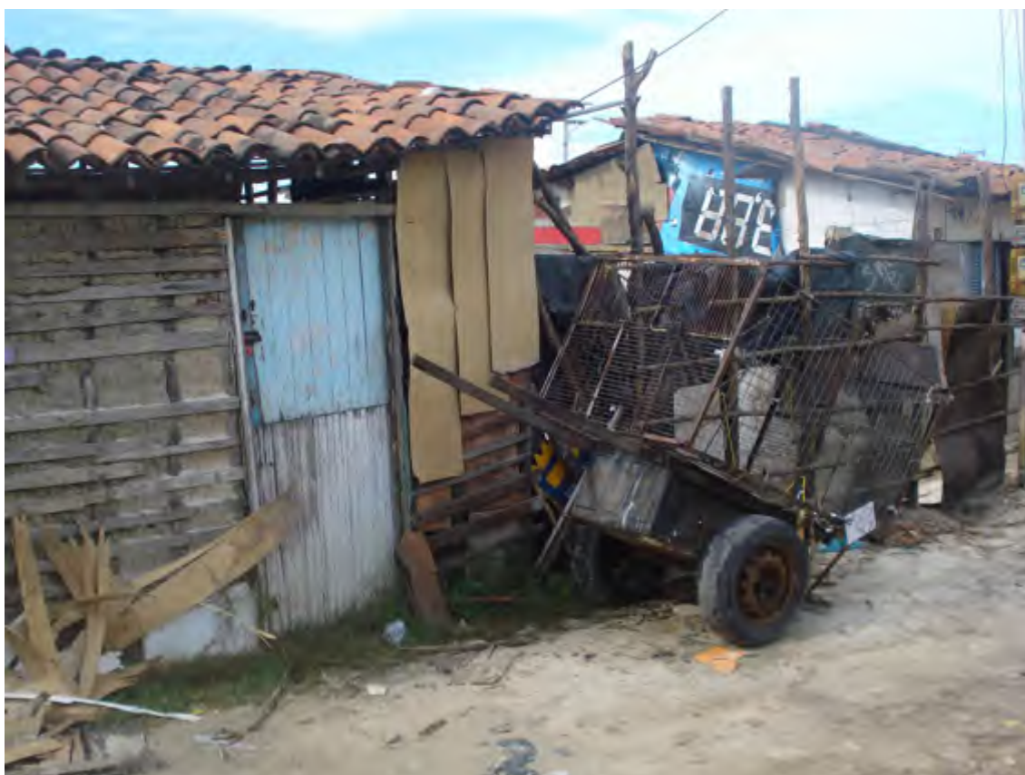
FOTO 28 – Aspecto de uma moradia da comunidade do mangue do bairro Vila Velha. Notar as precárias condições da moradia em questão. Fotografia realizada pelo autor em 21 de Maio de 2008.
