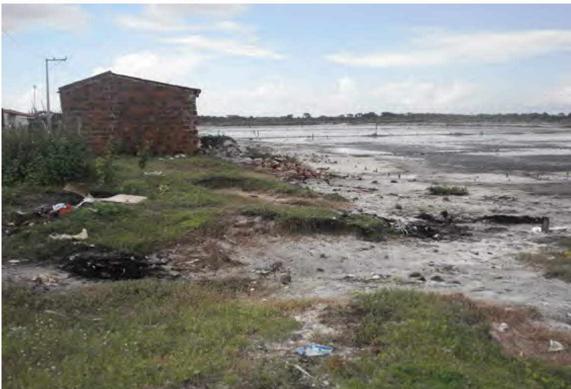
FOTO 15 – Moradia situada sobre a antiga área de salinas da comunidade do mangue do bairro Vila Velha. Notar a área inundada pelas oscilações de maré da planície flúvio-marinha, em um trecho à margem direita do Rio Ceará. Fotografia realizada pelo autor em 09 de Maio de 2008.
