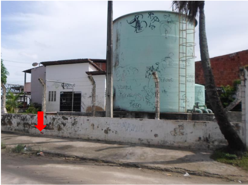
Figura 3.22 – Seta indicando local de instalação do poste, em frente à ETE Pindorama (Rua Júlia Sales com Rua Pindorama).
