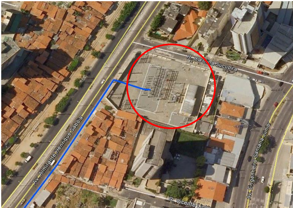
Figura 3.23 – Subestação Varjota, termino da LDAT implantada.
