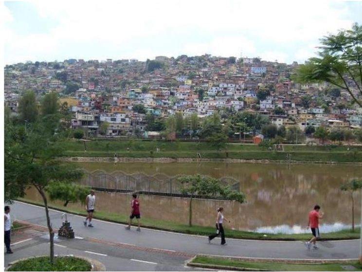
Figura 66. Bacia de detenção aberta com equipamentos públicos em Belo Horizonte-MG.
