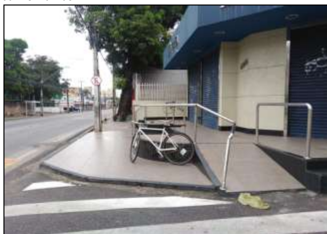
Figura 4. Exemplo de piso escorregadio na Av. João Pessoa, bairro Damas
