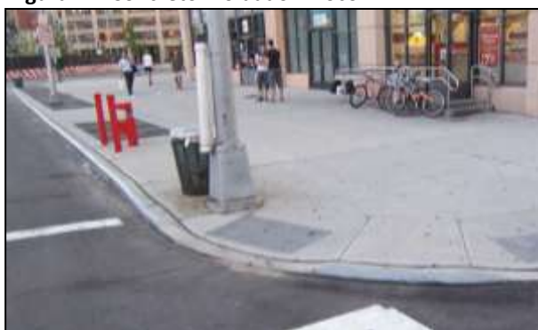
Figura 21. Concreto moldado in loco
