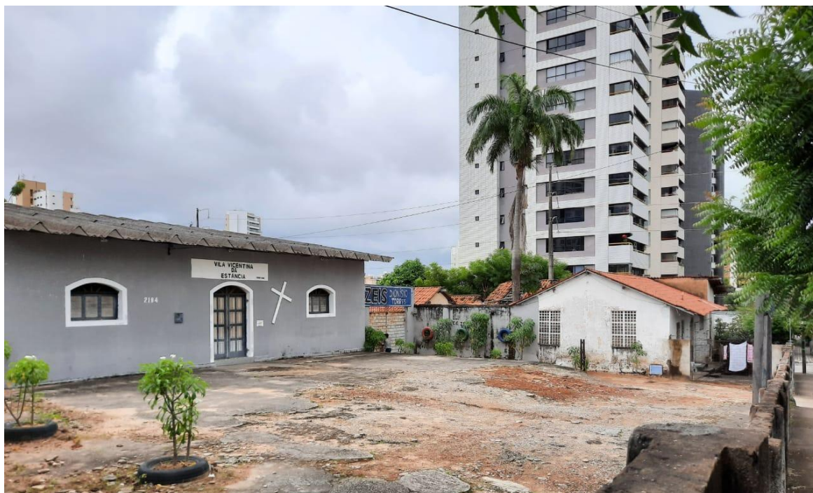
Figura 14: Capela da Vila Vicentina localizada na Rua Tibúrcio Cavalcante. Fonte: IPLANFOR, 2020.
