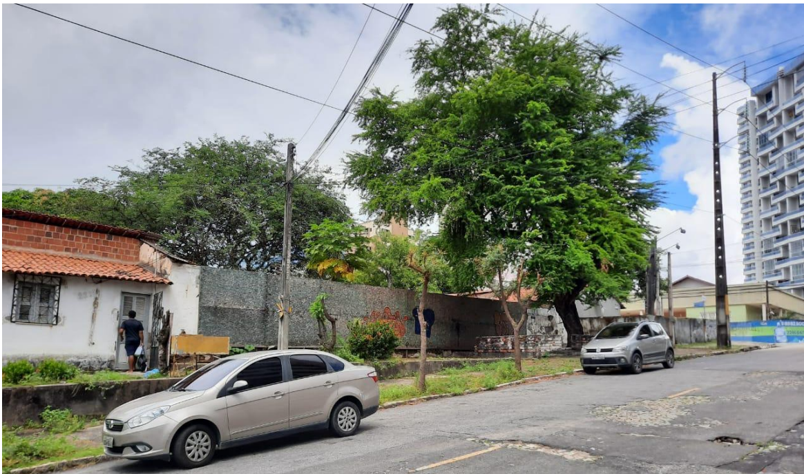
Figura 17: Casas demolidas na Rua Nunes Valente. Fonte: IPLANFOR, 2020.
