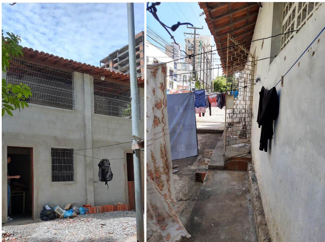
Figuras 25 e 26: Casa com morfologia e gabarito modificados/ Utilização da área frontal das residências. Fonte: IPLANFOR, 2020.
