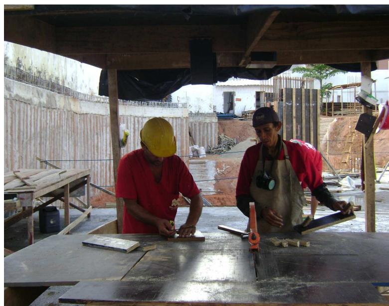
FIGURA 19 - Trabalhadores utilizando o “currupio” na obra da Mota Machado Fonte: MENDES, 2008
