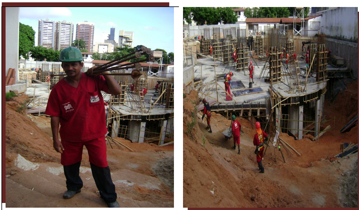
FIGURA 23 - Operários da Construção Civil na Obra da Construtora Mota Machado Fonte: MENDES, 2008
