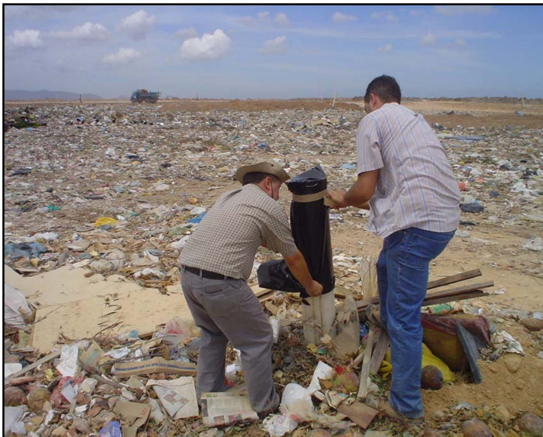
Selamento de drenos de gases no setor S2
