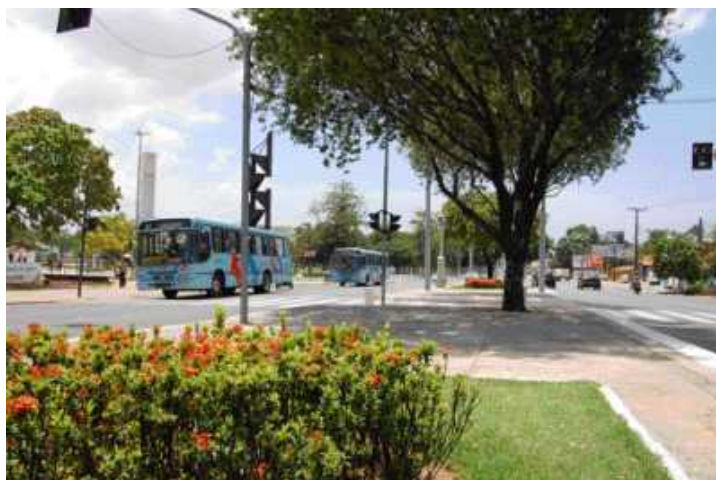
Canteiro central da avenida Paranjana
