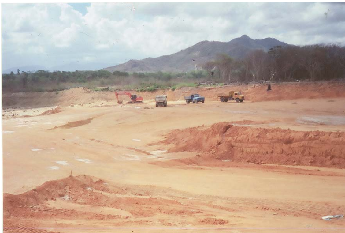
ESCAVAÇÃO DE CÉLULAS
