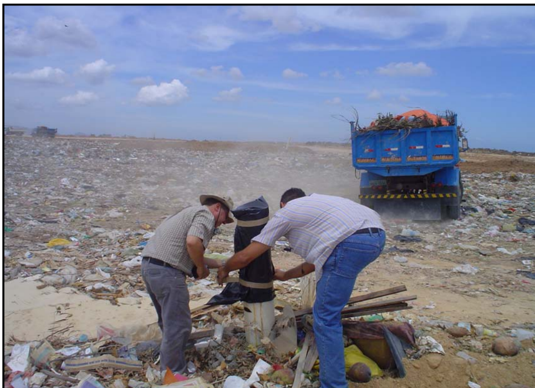
Selamento de drenos de gases no setor S13
