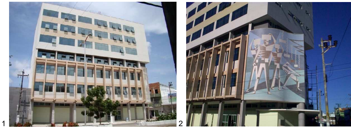
Figura 9: Centro de Exportadores do Ceará (1962) – 1: Foto do edifício reabilitado; 2: Detalhe do Mural “Estivadores” de Zenon Barreto (Fonte: Acervo Arq. Rafael Cunha)
