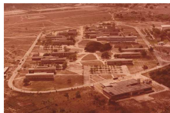
Figura 2: Vista aérea do Campus do Pici – Década de 1970 – Restaurante Universitário no primeiro plano, projeto de Neudson Braga. (Fonte: UFC - Coordenadoria de Obras e Projetos)
