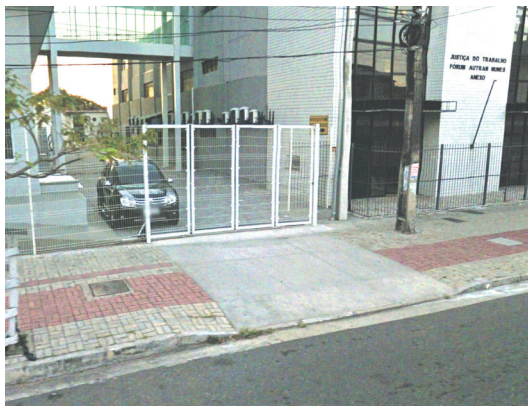
Exemplo de rampa de acesso de veículo ao lote com desenho adequado. (Av. Tristão Gonçalves).
