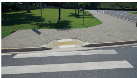
Exemplo de rampa acessível para calçada.
