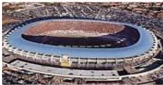
Figura 4: Vista aérea da configuração física atual do Castelão - futebolcearense.com.br
