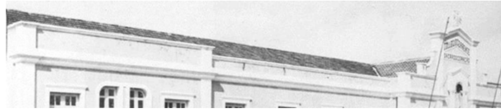
Figura 16 - Recorte de imagem antiga onde se pode perceber a utilização da telha francesa tipo Marselha.
