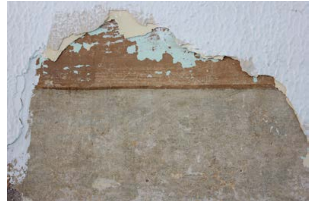
Figura 21 - Parede de um dos Martelos sugerindo a existência de pinturas históricas nas camadas mais próximas ao reboco.
