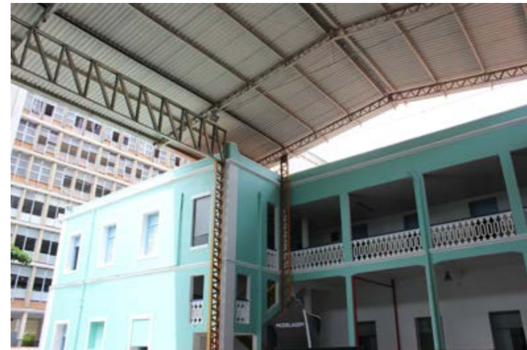
Figura 13 - Fachada interna, mostrando os balaústres de proteção da circulação, a fachada de um dos Martelos e a coberta metálica do Pátio Central. Fonte: SECULTFOR
