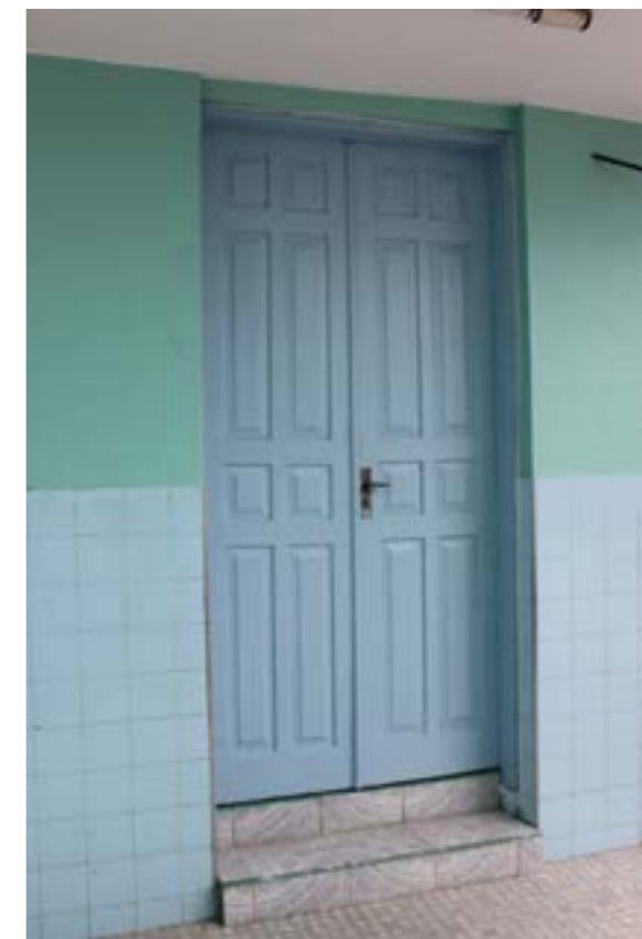
Figura 17 - Azulejos azuis colocados na base do prédio principal. Fonte: SECULTFOR
