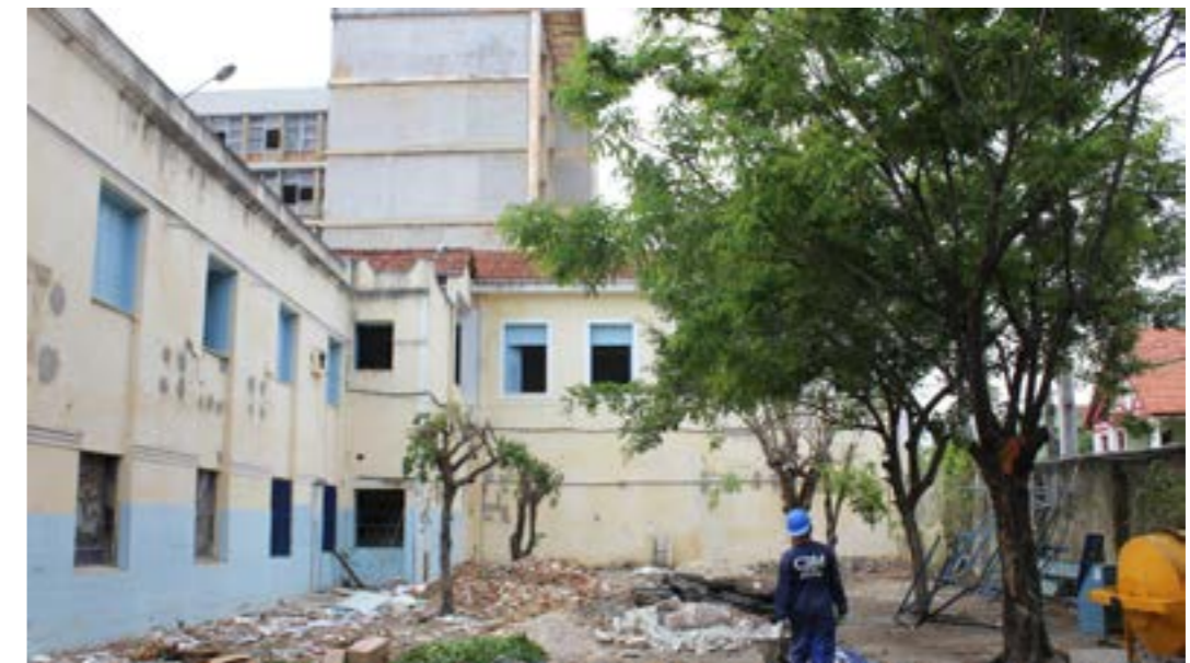
Figura 12 - Fachadas oeste da Capela e norte do Martelo Fonte: SECULTFOR
