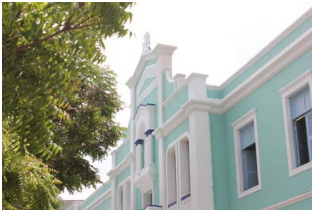
Figura 07 - Detalhe da fachada principal do Colégio Marista Cearense. Fonte: SECULTFOR
