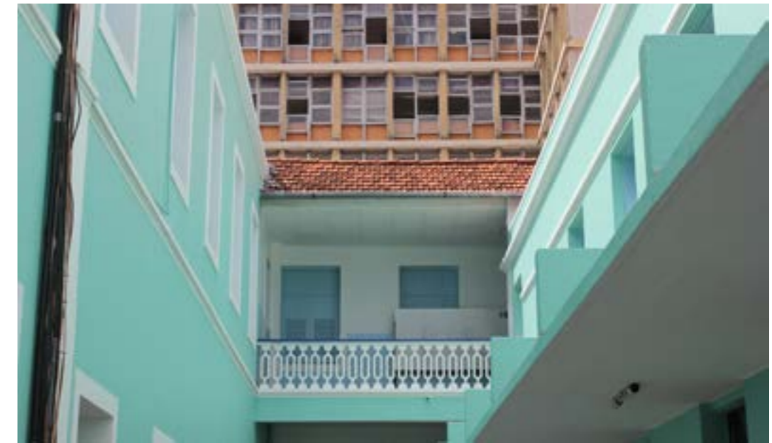
Figura 11 - Marquise na fachada lateral leste da Capela. Fonte: SECULTFOR
