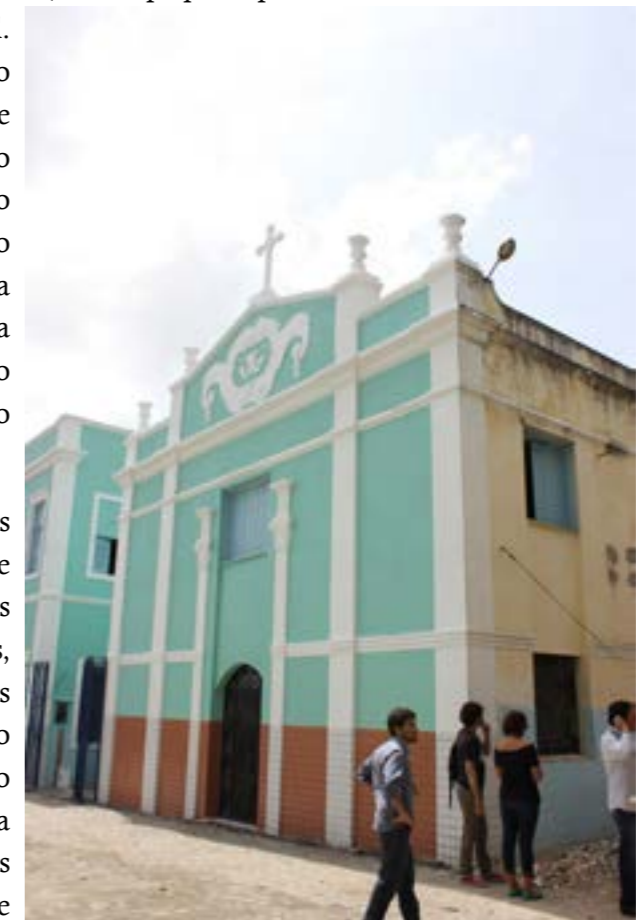
Figura 08 - Fachada da Capela. Fonte: SECULTFOR
