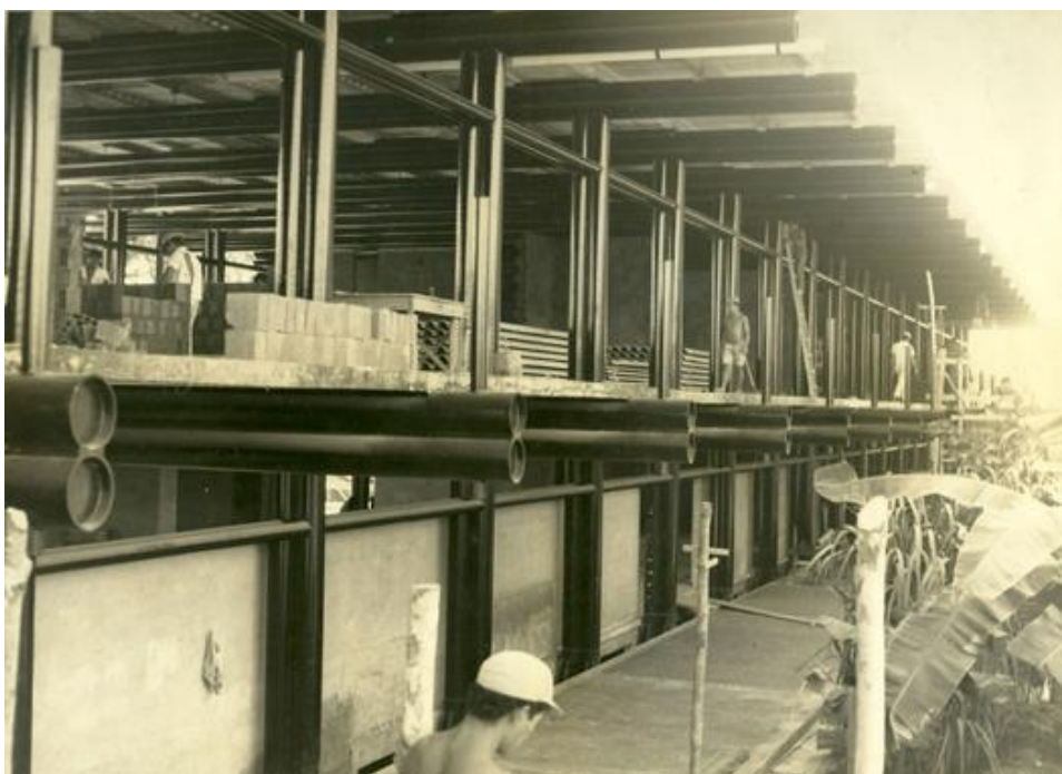
Figura 17 - Tubos utilizados na obra do Palácio que lembram os troncos de carnaúba, muito utilizados em construções no Ceará. 360
