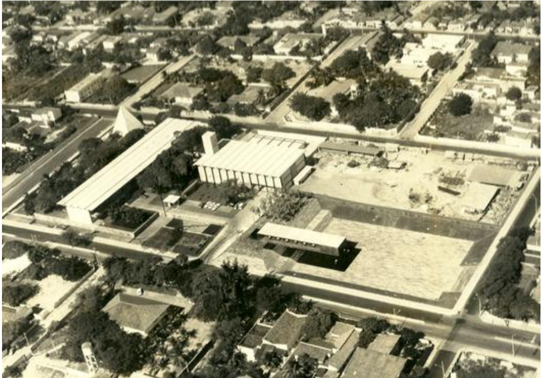
Figura 12 - Execução das obras do Conjunto Arquitetônico Palácio da Abolição. 350
