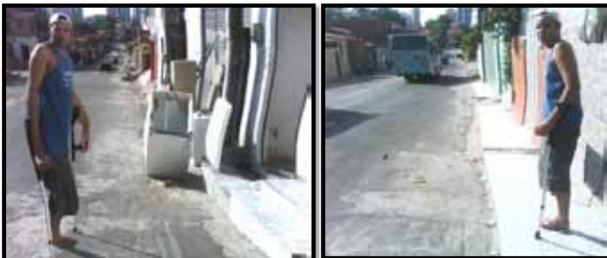
Fotos 30 e 31: Passeio ocupado de forma irregular e pavimentação inadequada. Fonte: Arquivo pessoal da autora.
