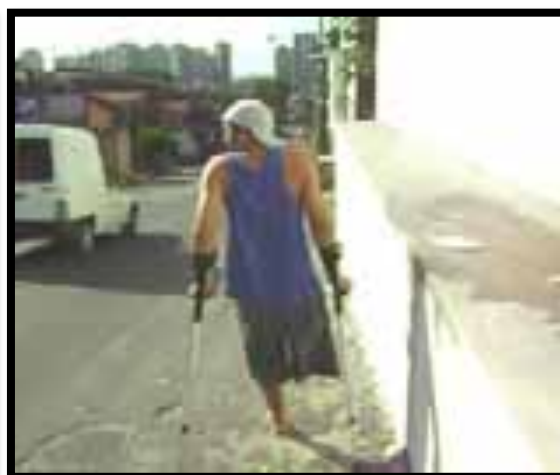
Foto 25 e 26: Mostram problemas de desnível do passeio que não acompanha o greide da rua e mobiliário dificultando a circulação em decorrência da invasão do passeio. Fonte: Arquivo pessoal da autora.
