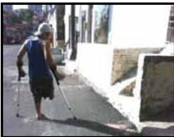
Foto 25 e 26: Mostram problemas de desnível do passeio que não acompanha o greide da rua e mobiliário dificultando a circulação em decorrência da invasão do passeio. Fonte: Arquivo pessoal da autora.
