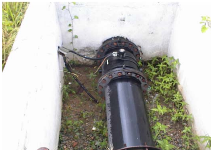
Figura 3.9. Medidor magnético de vazão
