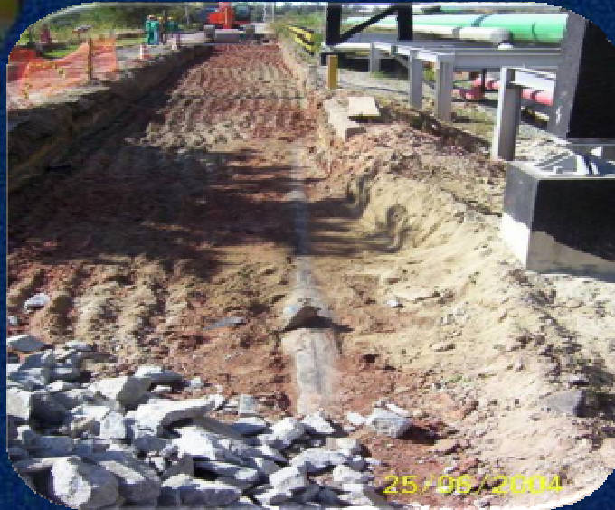
Máquina toca a superfície do Duto
