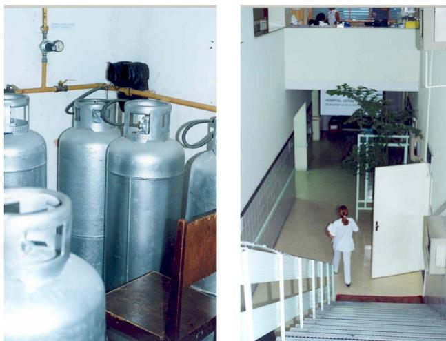
Figura 4.9 – Localização da Central de GLP e detalhe de escada sem corrimão
