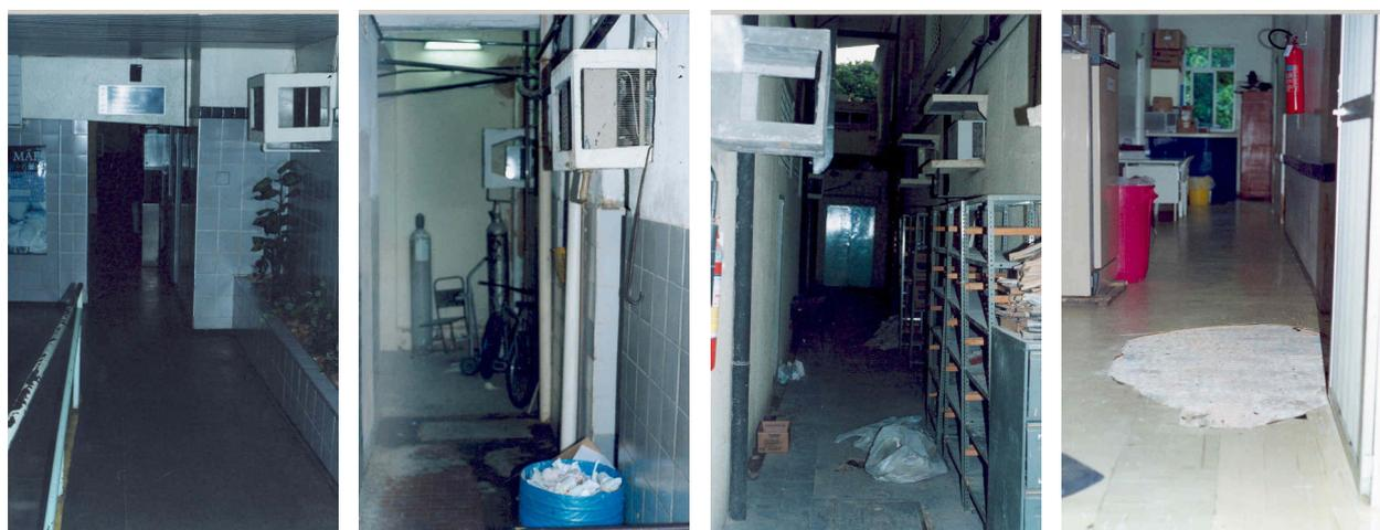
Figura 4.11 – Circulações com espaços vazios, materiais em desuso e pisos danificados
