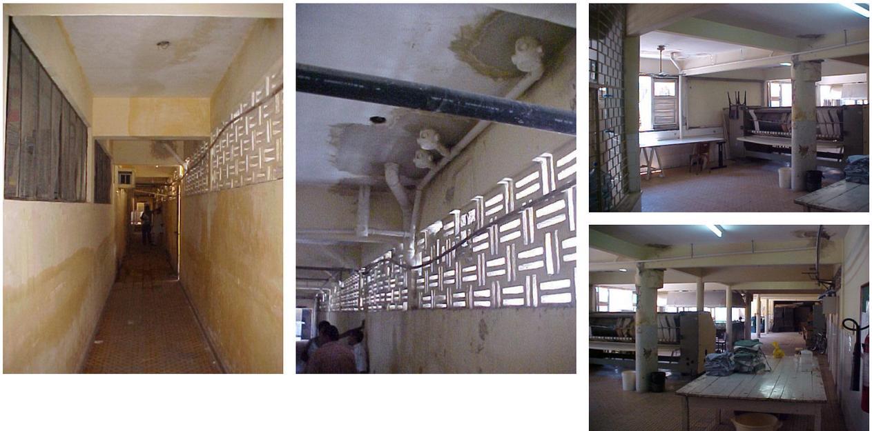
Figura 4.39 – Circulações desativadas, tubulações expostas, instalações mal conservadas
