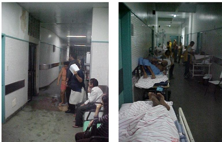
Figura 4.17 – Bloco da Emergência, circulação obstruída, infiltração com vazamentos no teto
