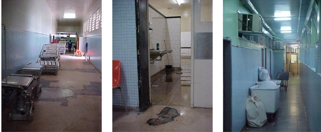
Figura 4.25 – Circulações obstruídas, revestimento de piso precário e aquecimento no ambiente
