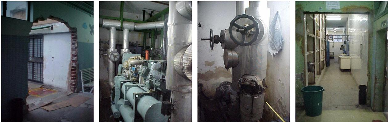
Figura 4.26 – Demolição em parede para passagem de equipamento e instalações precárias
