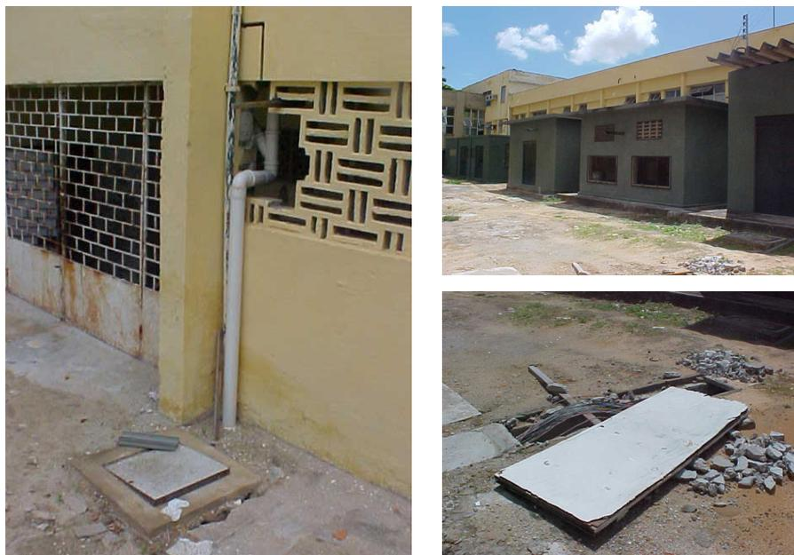
Figura 4.36 – Tubulações aparentes e desviadas, grupos geradores e área interdita
