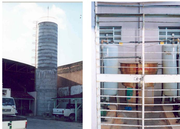
Figura 4.4 – Reservatório em anéis premoldados com pára-raios / Central de Vácuo
