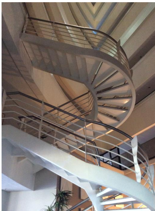
Figura 96 - Othon Palace Fortaleza: escada de acesso ao 2º pavimento
