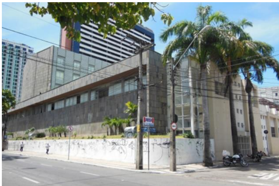
Figura 121 – Fachadas: esquina leste/sul
