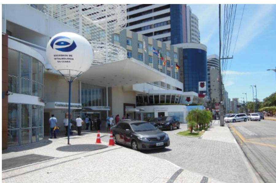
Figura 120 - Acessos e marquise
