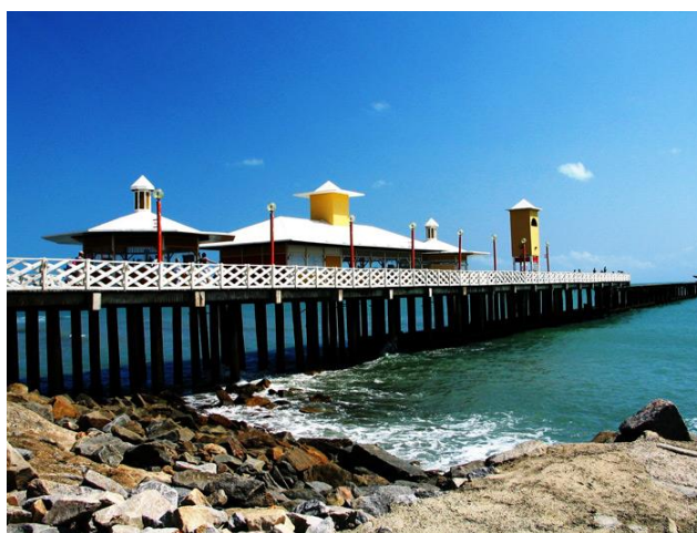
Figura 14 - Ponte dos Ingleses
