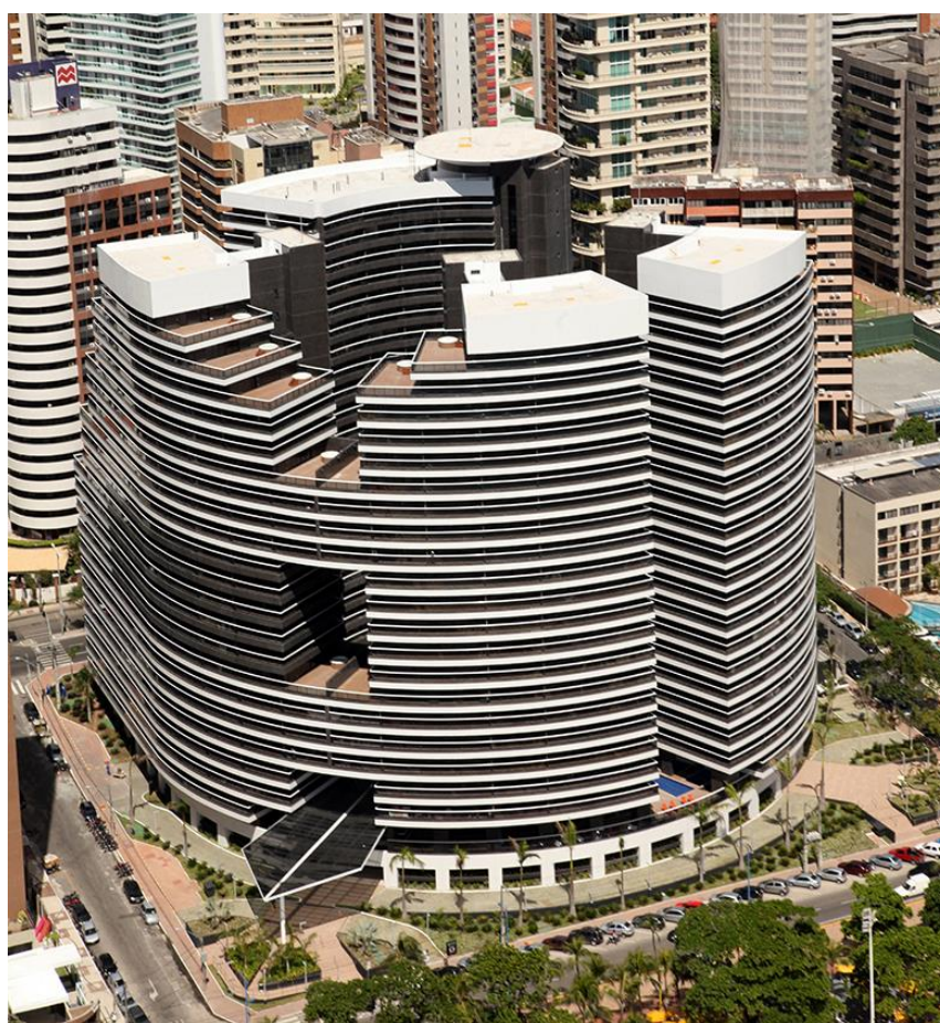
Figura 109 - Vista das coberturas e aberturas nos planos de fachada
