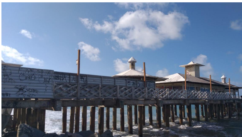
Foto 02 – Vista pela lateral direita da Ponte dos Ingleses.
