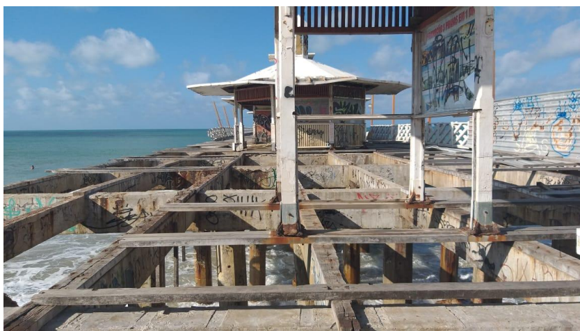
Foto 03 – Vista interna frontal da Ponte dos Ingleses.
