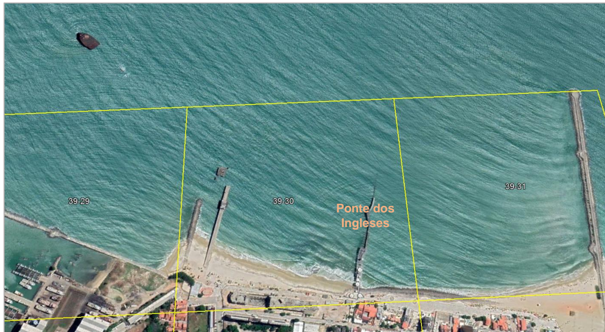
Figura 02 - Base cartográfica da área de interferência da Ponte dos Ingleses.
