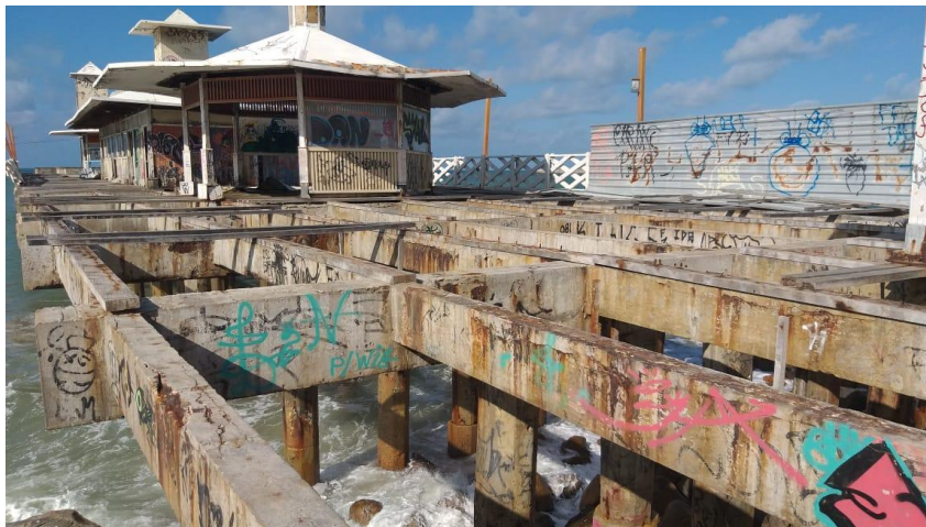
Foto 04 – Vista interna da Ponte dos Ingleses.
