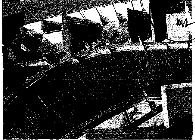
Visão Superior da Rampa
