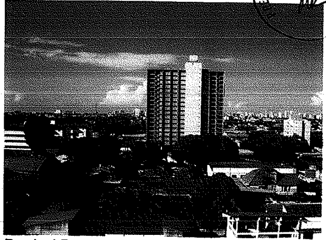
Rua José Façanha
