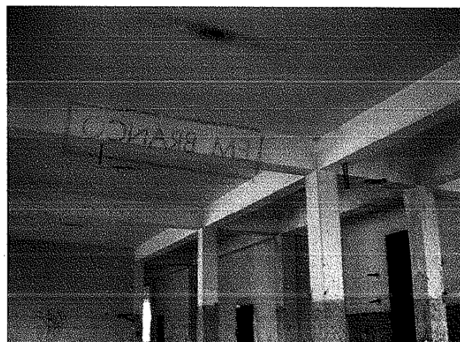
Estrutura de Pilares e Vigas
