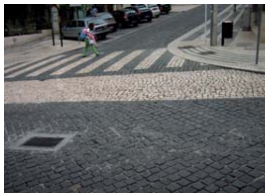
Calçadas e faixas de pedestres utilizando material em cores diferentes. Guimarães, Portugal. 2011. Foto: George Alex da Guia.
