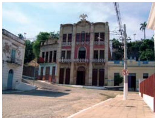
Calçadas e edifícios sem acessibilidade. Corumbá/MS. 2010. Foto: Renata Ceridono Fortes.
