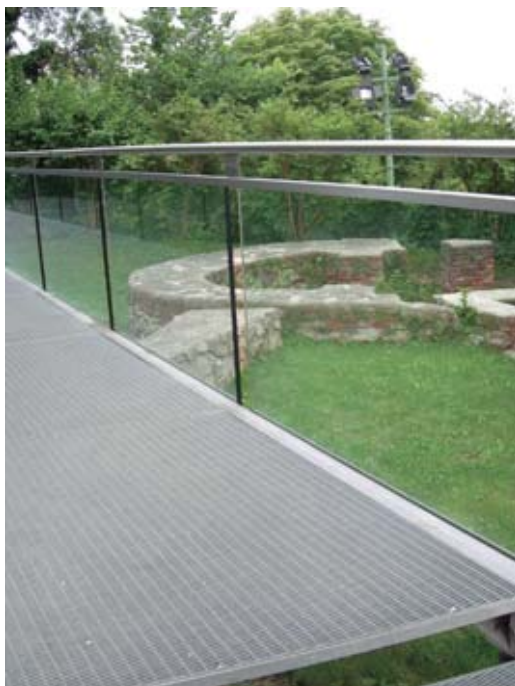
Passarela com guarda-corpo em vidro. Foto: Acervo Iphan.
