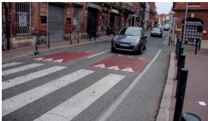
Faixa de pedestre com redutor de velocidade e calçadas asfálticas na cor vermelha. Toulouse, França. 2011. Foto: Sandra Bernardes Ribeiro.
