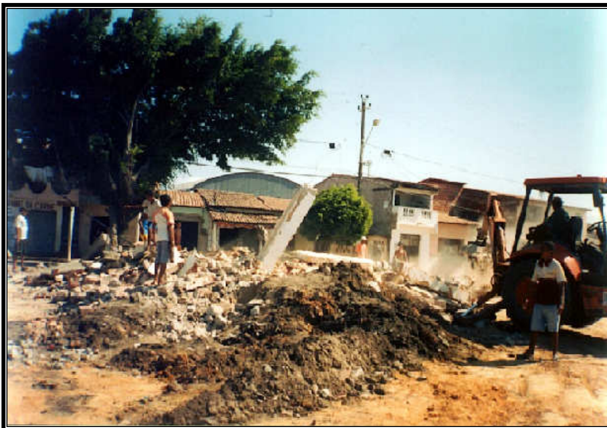
Imagem 14. Demolição de casas na Lagoa do Opaia no bairro Vila União, em 2001, através do Programa Pró-moradia Habitar Brasil/BID. Ao fundo, casas e galpão para aeronaves do antigo Aeroporto. Foto gentilmente cedida pelo Habitafor.
