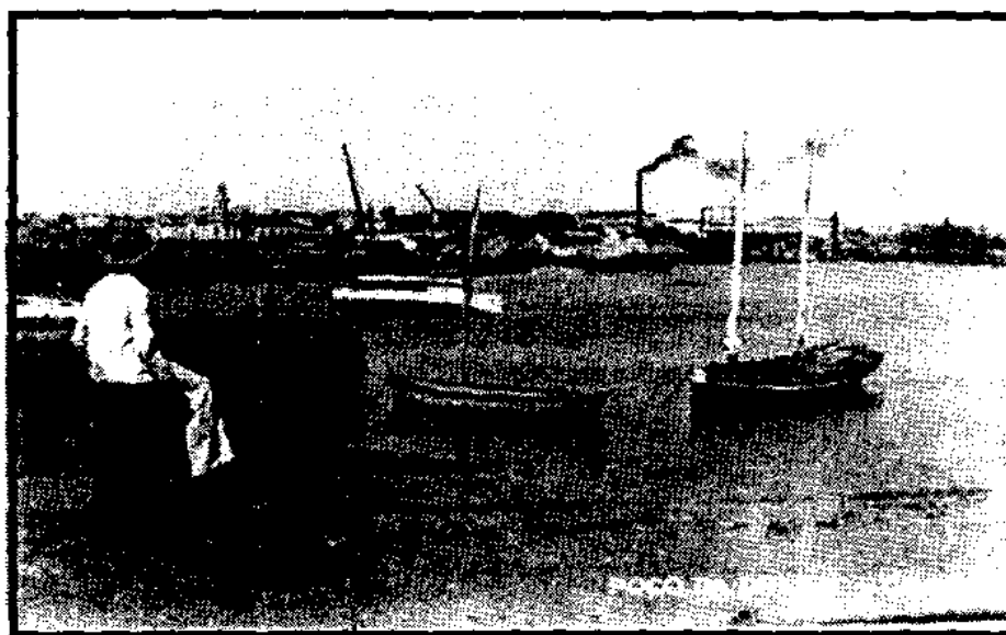
Poço da Draga. (Arquivo Nirez)
